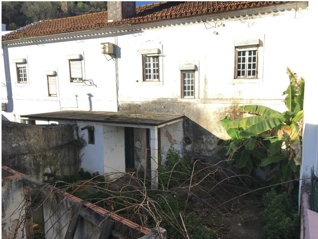
Figura 14 – Fachada e logradouro tardez do edificado;
