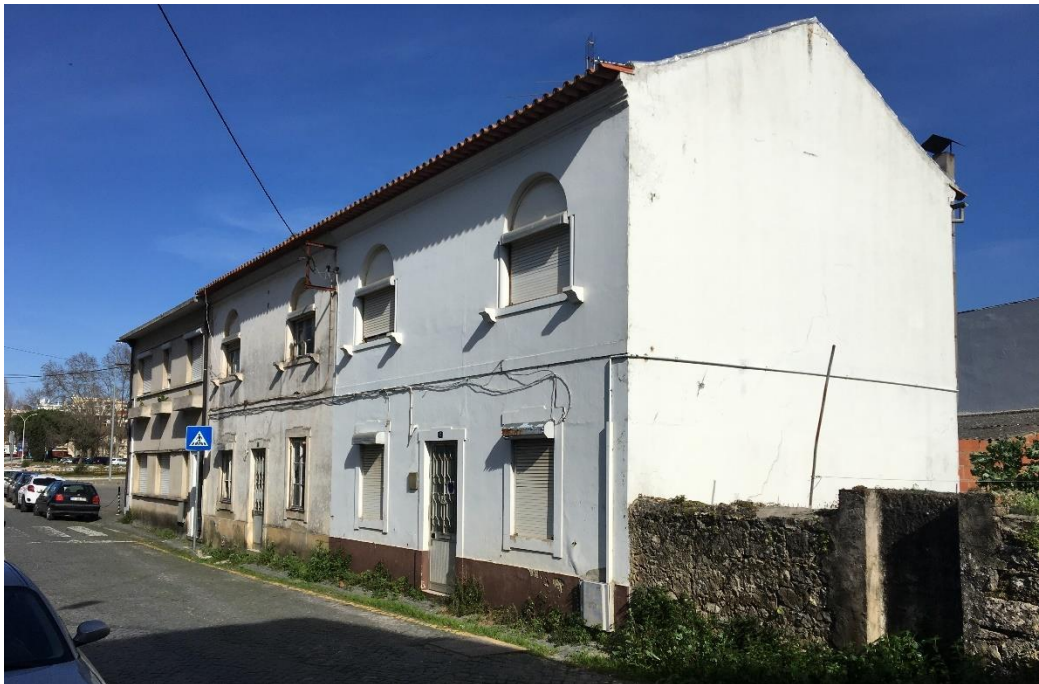
Figura 13 – Fachada principal e lateral do edificado existente;
