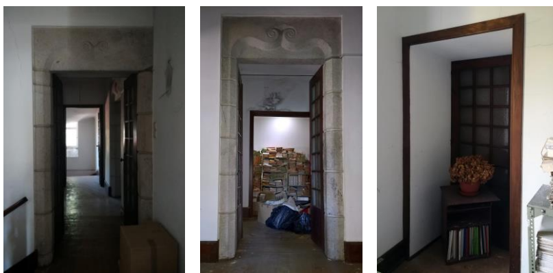
Figura 31 – Aberturas nas paredes estruturais do piso 1.
