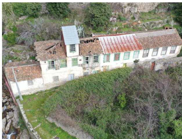
Figura 11- atual situação edifício 4 (fonte: drone da UBI)
