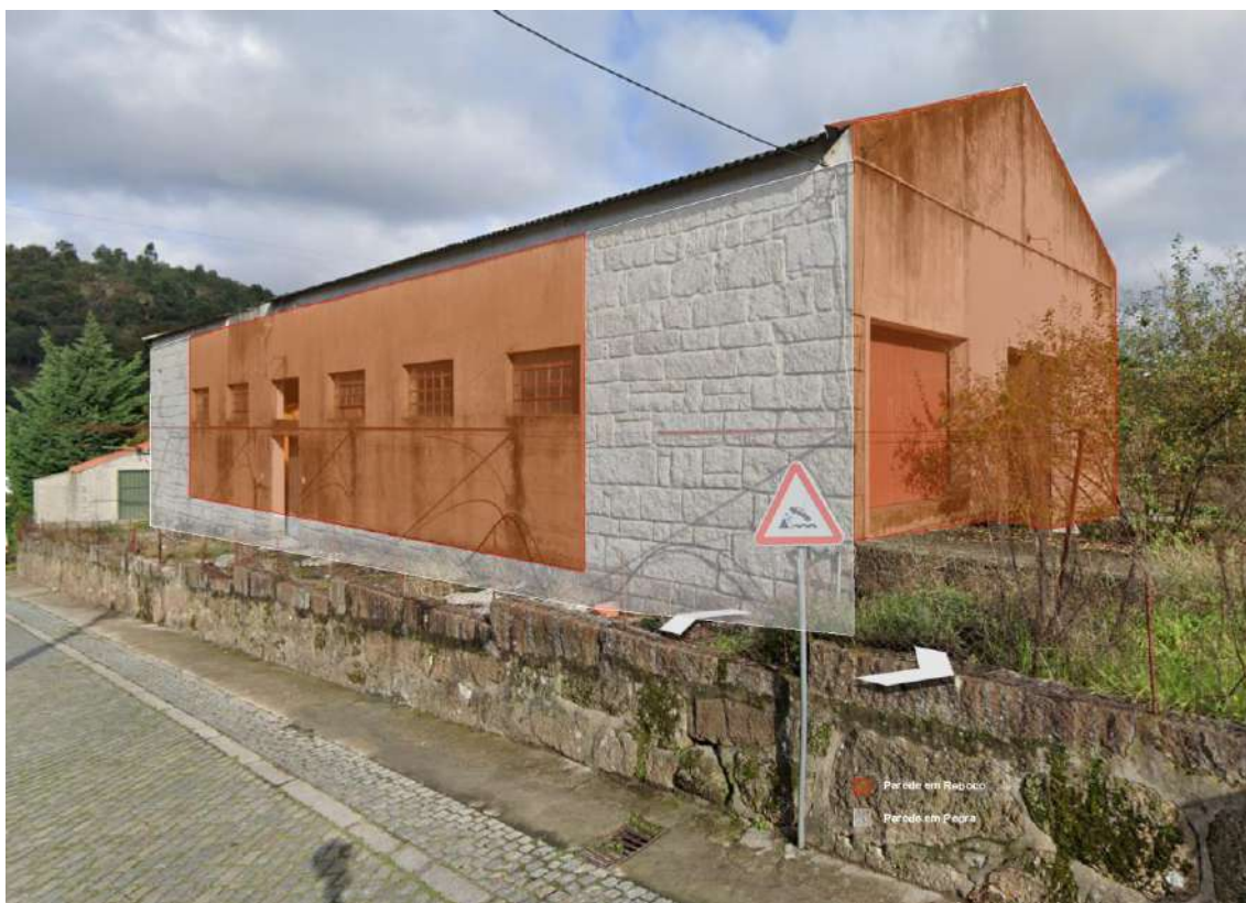
Figura 38. Distinção dos materiais da fachada do armazém
