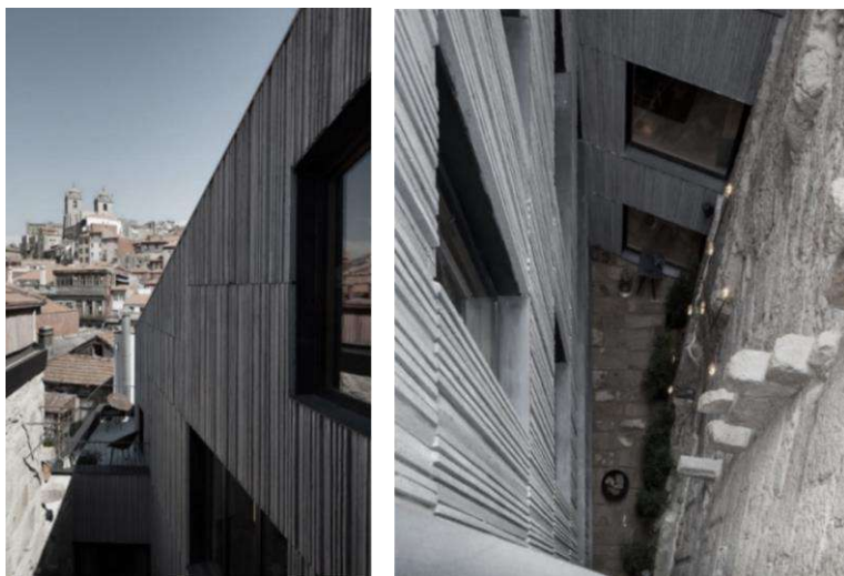
Figura 25. Exterior do Armazém de Ferro | Fonte pedraliquida.com
