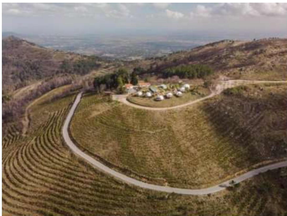
Imagem 3. Vista aérea da estrada da floresta na encosta da colina.
