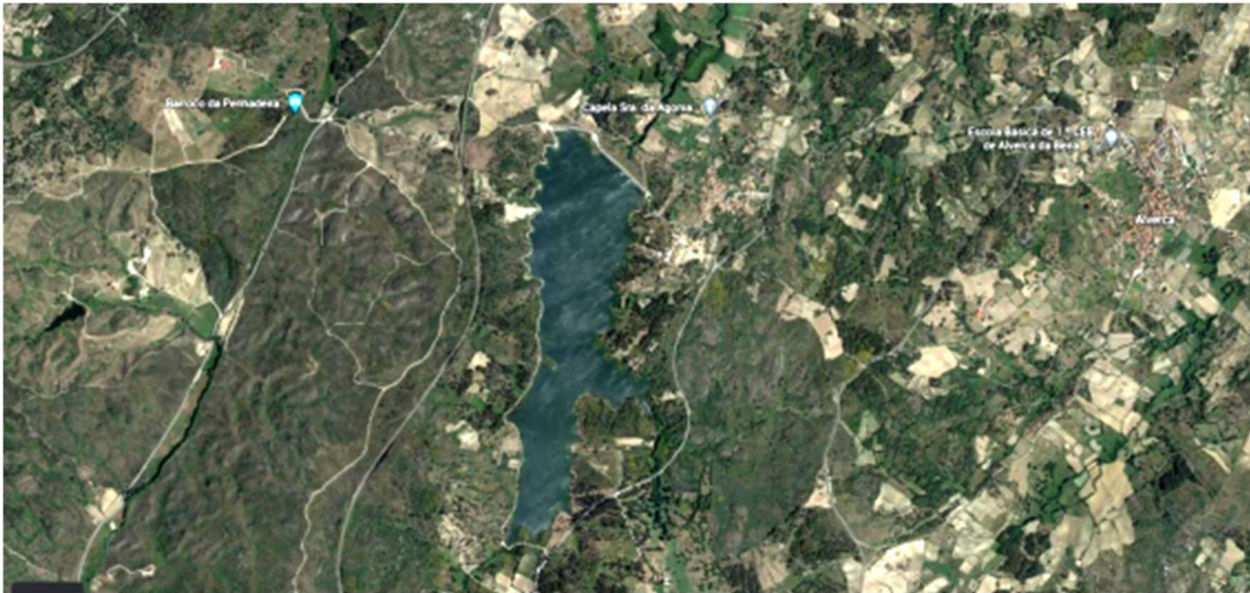
Figura 6. Vista por satélite da Barragem de Bouça Cova
