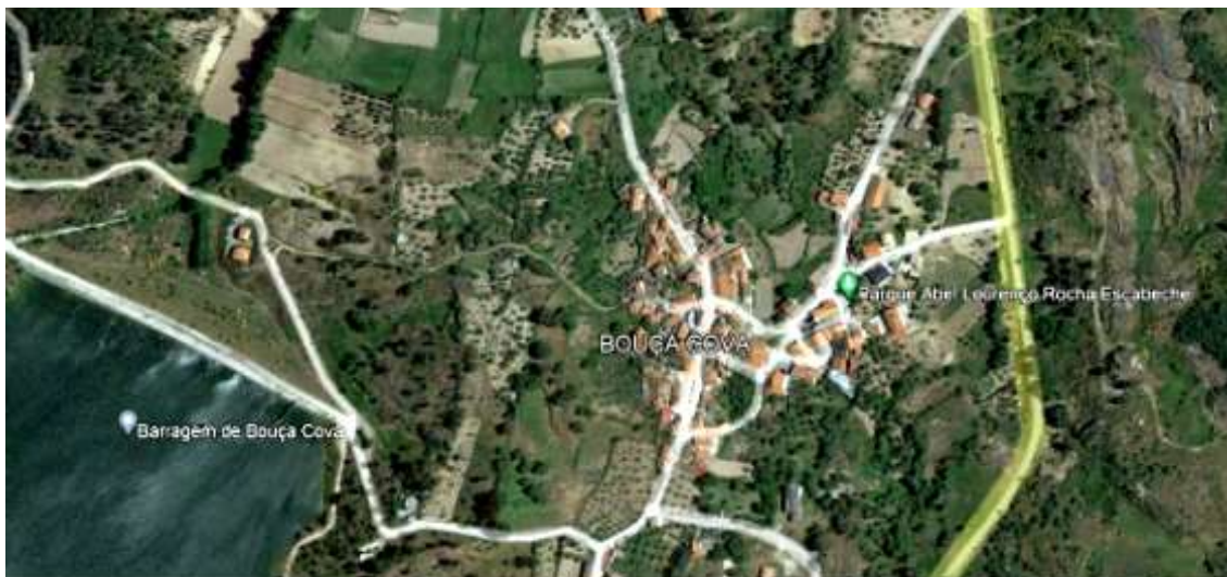
Figura 5. Vista aérea da aldeia de bouça cova e da barragem.
