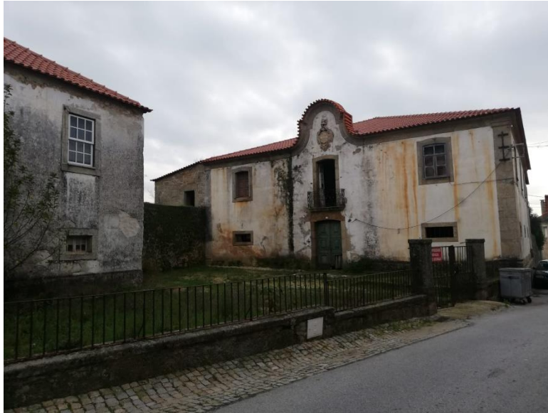
Figura 36: Acesso principal ao Solar
