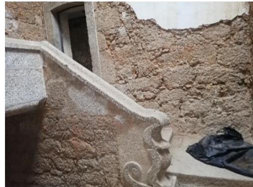
Figura 30: Detalhe da cantaria da comunicação vertical
