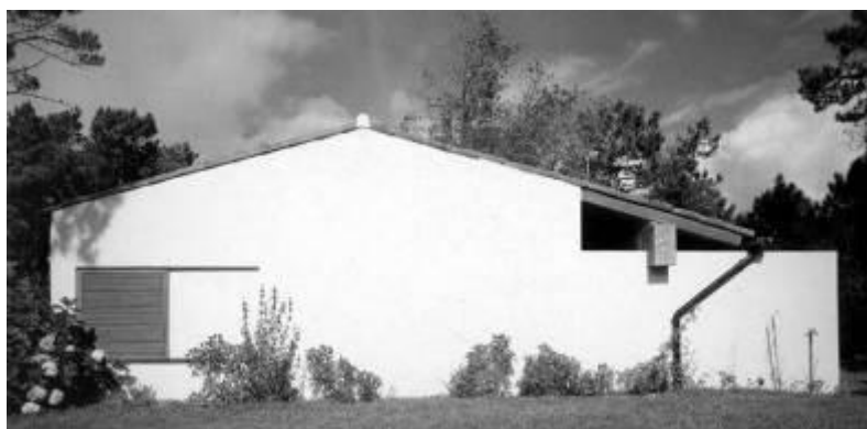
Fig.56 Casa de Ofir, fachada Este, entrada principal, fotografia de Rui Moraes de Sousa
