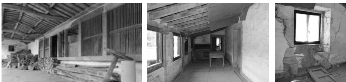
Fig. 42 Eira coberta e espigueiro embutido, Foto da autora, 2022
