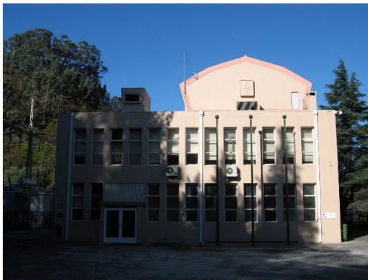
Figura 57. Edifício de comando e descarga (Fonte: LINK )
