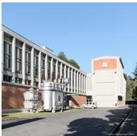
Figura 59. Central de Caniçada (Fonte: LINK )
