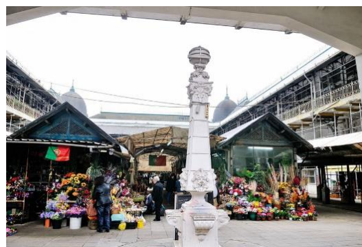
Figura 26. Vista central do mercado (Fonte: LINK )
