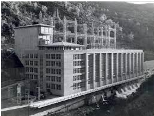
Figura 55. Edifício de comando e descarga (Fonte: LINK )
