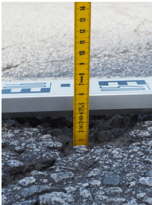
Figura 42 - Ninho DS 1: medição da profundidade em campo
