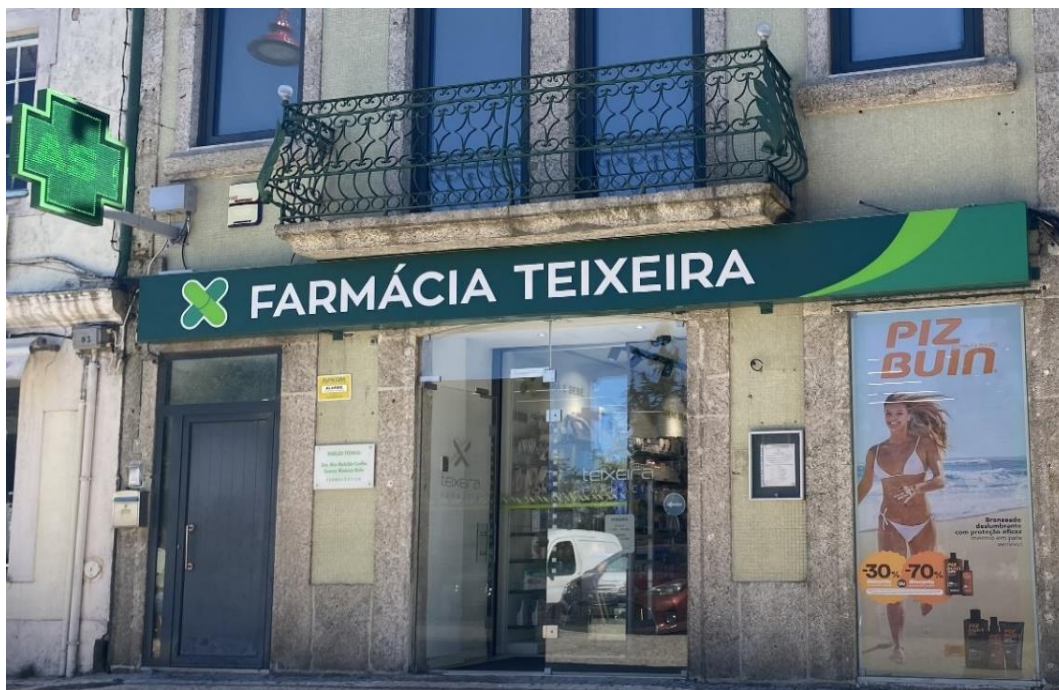
Figura 19- Espaço exterior da FT.
