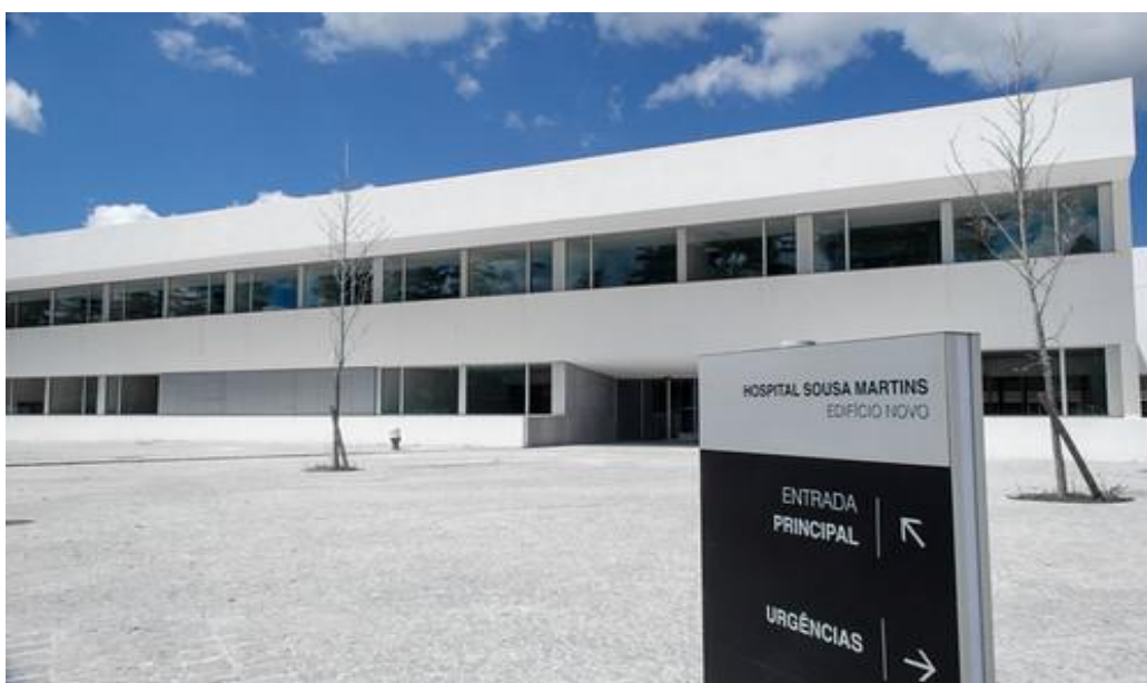
Figura 22 - Edifício novo do HSM da ULSG, E.P.E. (9)
