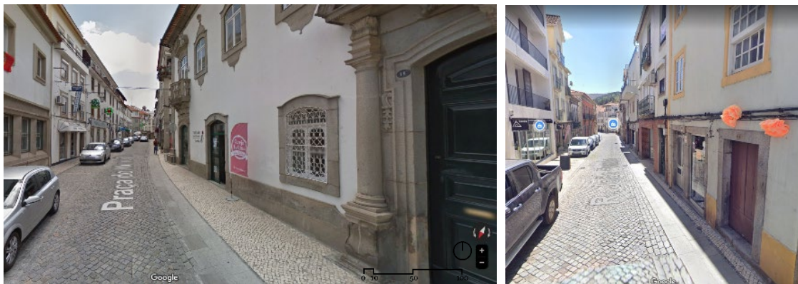
Fig. 32 e 33 - Imagem da rua João Franco, onde destaca-se a ausência de degraus do passeio para a rua. Na imagem à direita, destaca-se a largura inapropriada do passeio na mesma rua, e evidencia-se também que no passeio oposto, há carros estacionados, o que dificulta a mobilidade nestas partes. Imagens extraídas do google maps .
