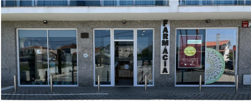
Figura 11 - Fachada da FHP.
