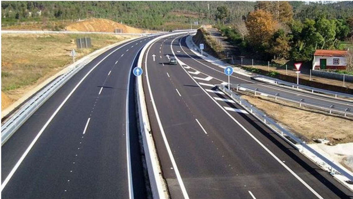
Figura 11 - Secções de convergência (junto a rampa de ligação) ( https://maps.google.pt )
