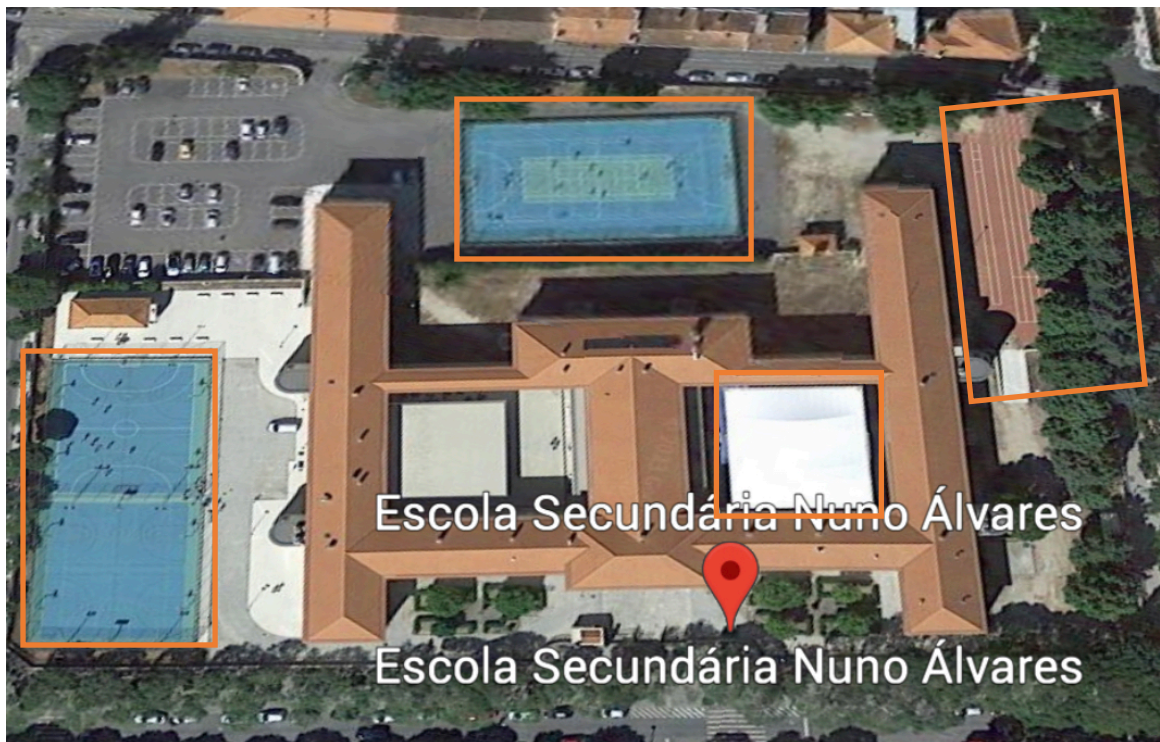
Figura 2 – Instalações desportivas da ESNA.
