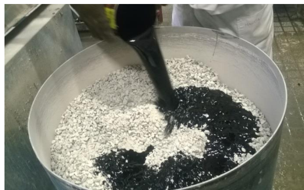
Figura 4.23 - Colocação da mistura na betoneira
