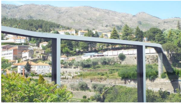
Fig. 11 - Ponte sobre a Ribeira da Carpinteira, 2009, Carrilho da Graça (Fonte: autor, 2015)
