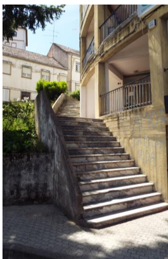
Fig. 26 - Escadas públicas sem corrimão (Fonte: autor. 2015)
