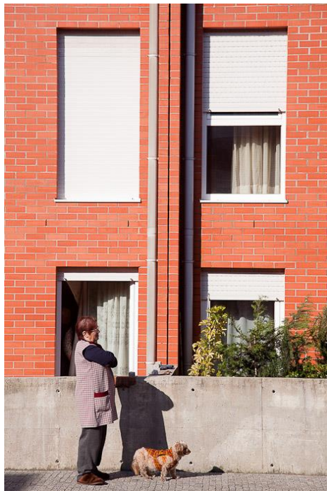
Fig. 46 - Bairro Monte de Espinho. Relação de proximidade entre espaço interior privado e exterior público Fonte: Alexandre Delmar e João Messias, 2009
