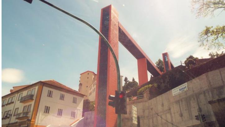
Fig. 16 - Vista dos dois elevadores e passadiços a partir da Rua Marquês de Ávila e Bolama (Fonte: autor, 2015)
