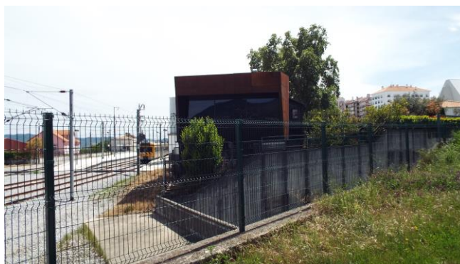
Fig. 29 - Proximidade com as principais fontes sonoras: comboios, trânsito no eixo TCT, discoteca. Fonte: Autor, 2015
