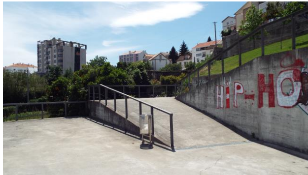
Fig. 37 - Muro para realização de actividades artísticas, actualmente vandalizado. Fonte: Autor, 2015
