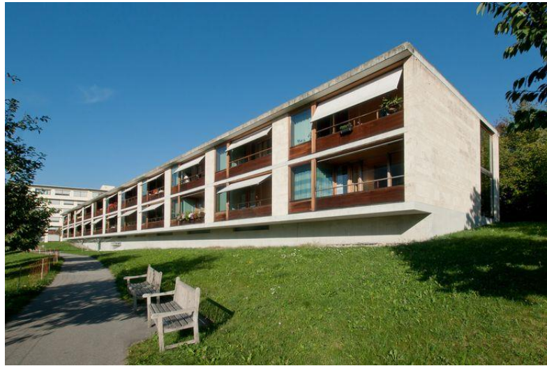
Fig. 53 - Alçado poente com varandas e nichos moldurados nas paredes de betão.
