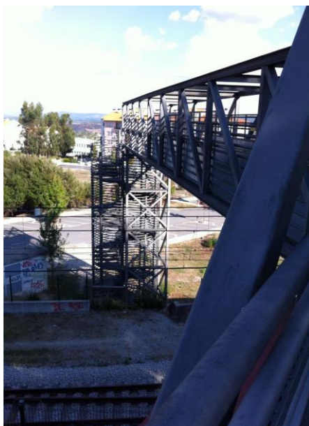
Fig. 8 - Ponte e escadas do Jardim do Rodrigo sob linha férrea. (Fonte: autor, 2015)
