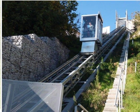
Fig. 14 - Elevador da Goldra, em movimento (Fonte: Gomes, 2015)
