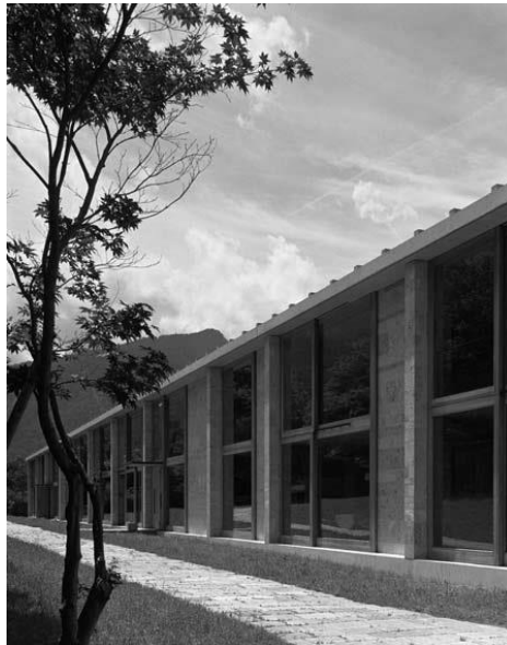
Fig. 59 - Alçado nascente. Verticalidade definida pelos pilares salientes, vãos envidraçados e planos de betão. Fonte: Helene Binet, s.d.
