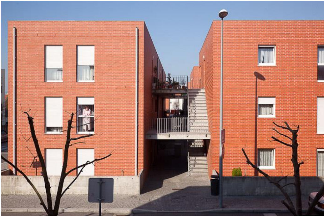
Fig. 44 - Bairro Monte de Espinho. Acessos verticais exteriores que ligam dois módulos habitacionais.
