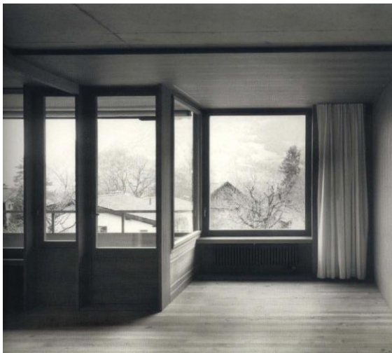
Fig. 55 - Interior da residência. Recanto envidraçado e varanda para uso no Inverno e Verão, respectivamente. Utilização de madeira como acabamentos.
