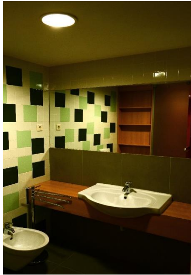
Figura 92 - Pormenor da instalação sanitária
