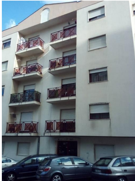
Figura 79 - Fachada principal do edifício onde se localiza o caso de estudo
