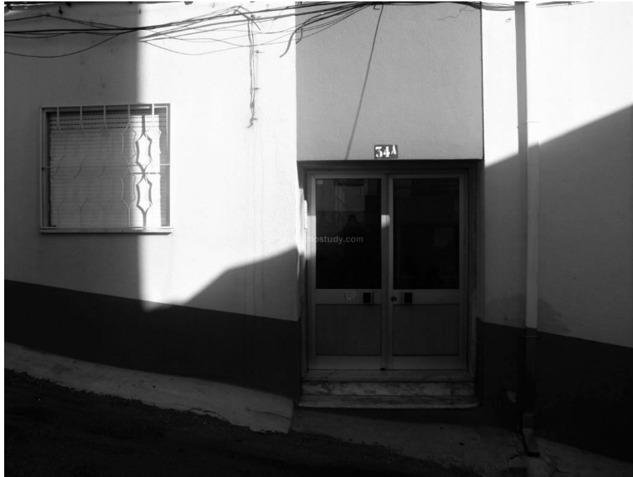
Figura 85 - Fachada onde se localiza o caso de estudo 8
