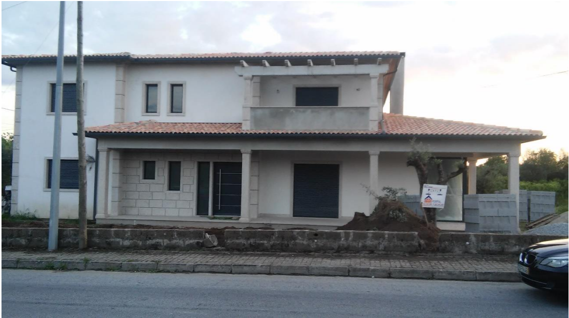
Figura 101 - Fachada principal da habitação em estudo
