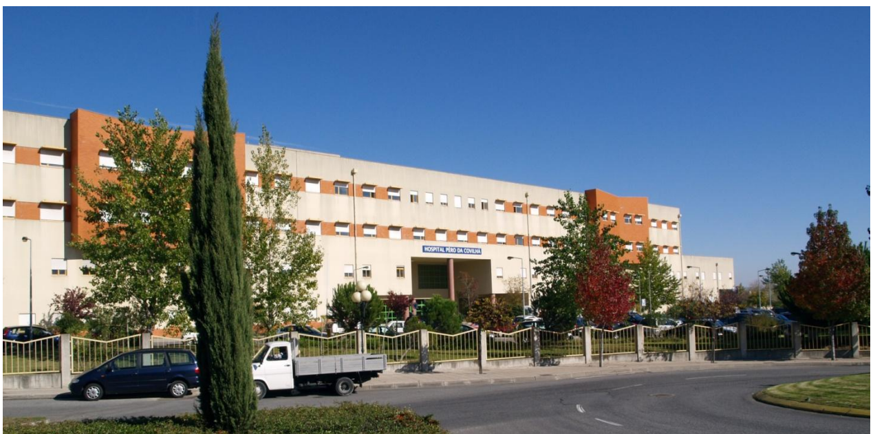
Figura 2. Hospital Pêro da Covilhã
