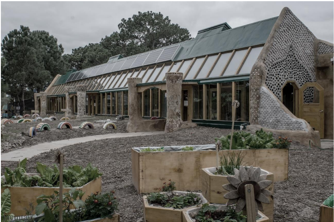
Figura 65 - A zona de entrada de uma Earthship onde se encontra a estufa e o jardim interior. Fotografia de Mueller Felix.
