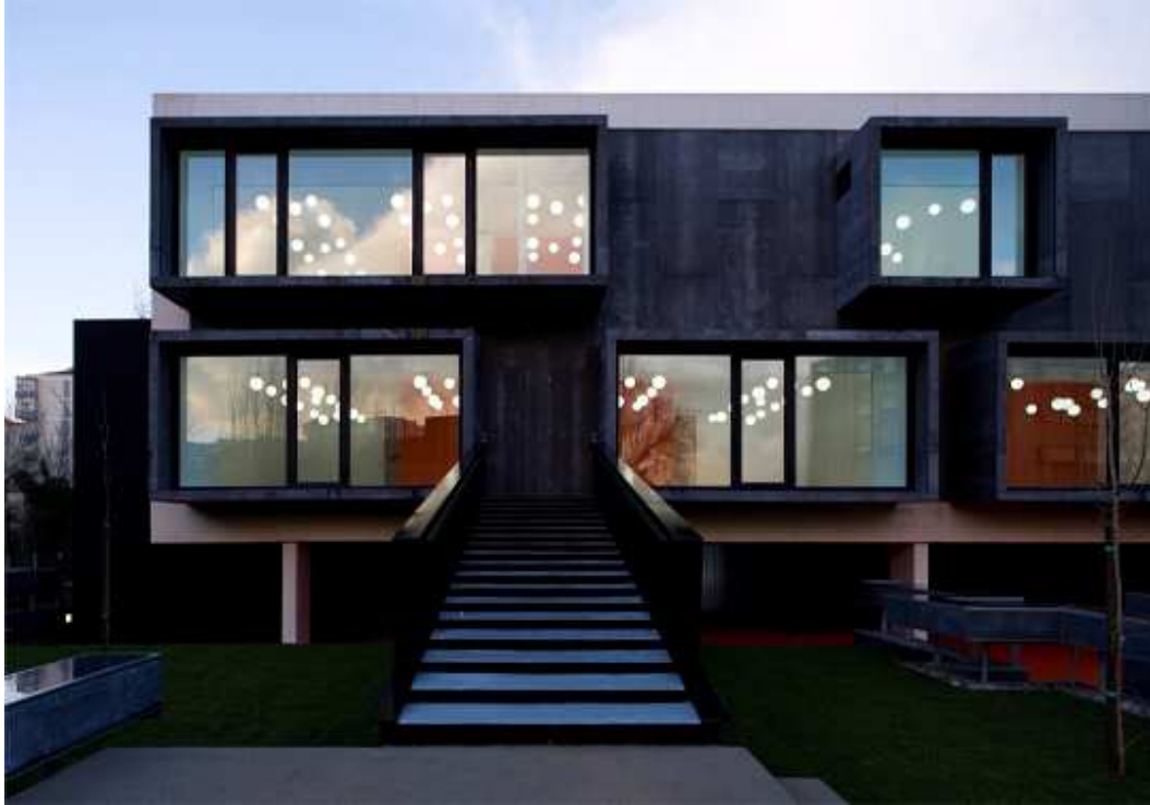
FIGURA 10 – JARDIM DE INFÂNCIA. FACHADA SUL.
