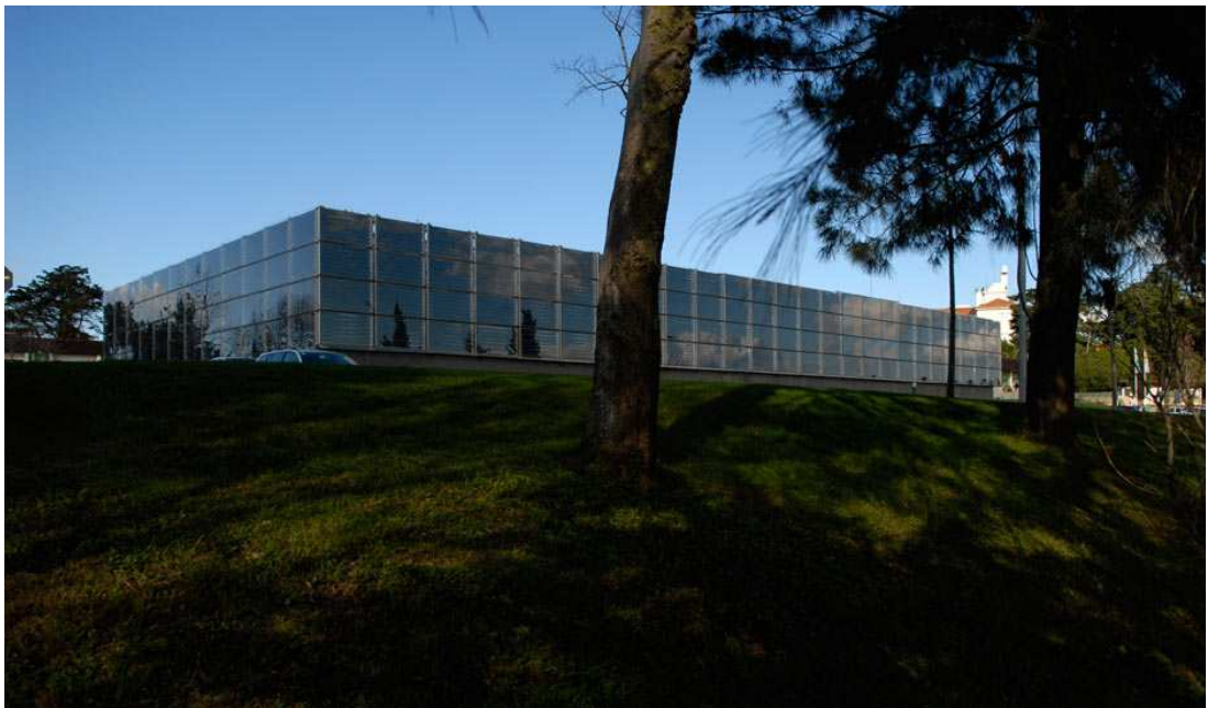
FIGURA 7 – CENTRO DE CONTROLO OPERACIONAL DA BRISA, FACHADA SUL E OESTE.
