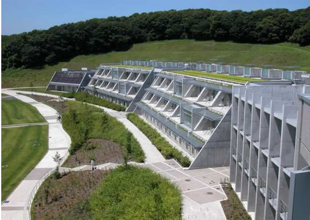
FIGURA 23 – FACHADAS ORIENTADAS A SUL.
