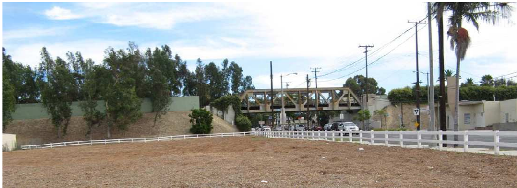
FIGURA 35 – TERRENO. VISTA PARA O TALUDE.
