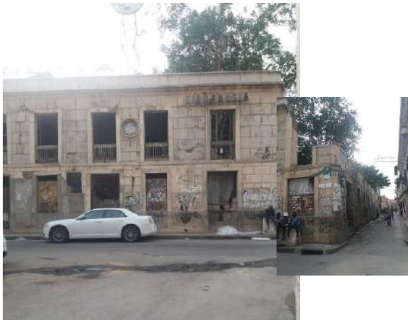
51 Ruínas Tipografia Minerva (fachada este)
