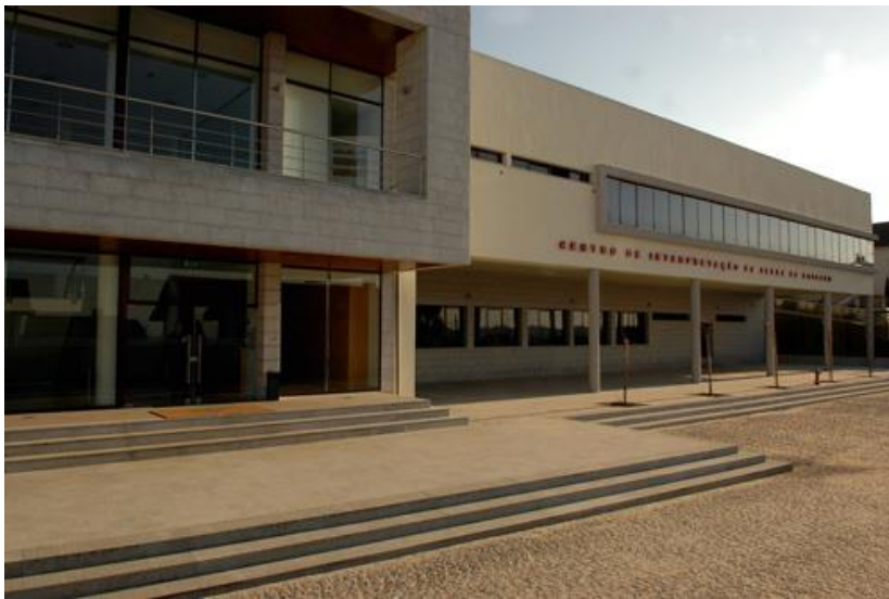
Fig. 55 - Vista exterior do CISE; Fonte: WEB 6; Autor: desconhecido
