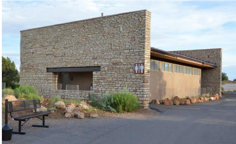
Fig. 86 - Exemplo de Instalações sanitárias públicas; Fonte: WEB 30 ; Autor: Quinn, M. (2011).
