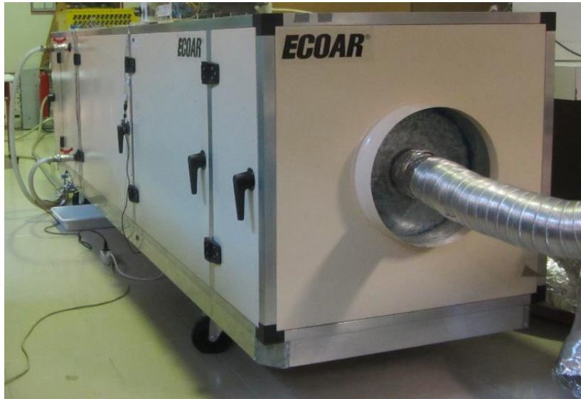
Figura 3.3 Unidade de tratamento de ar ECOAR
