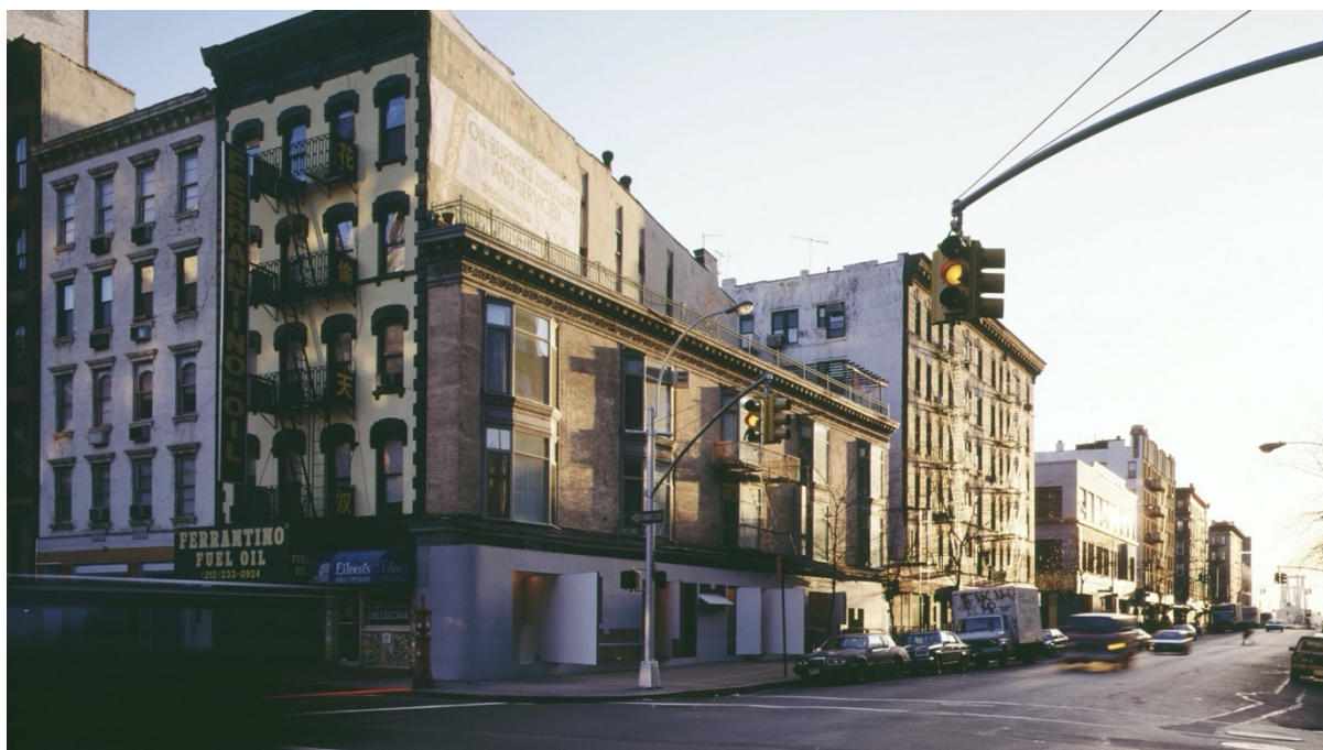
Figura 38 - Fachada do edifício "Storefront" (Steven Holl Architects, 1993).
