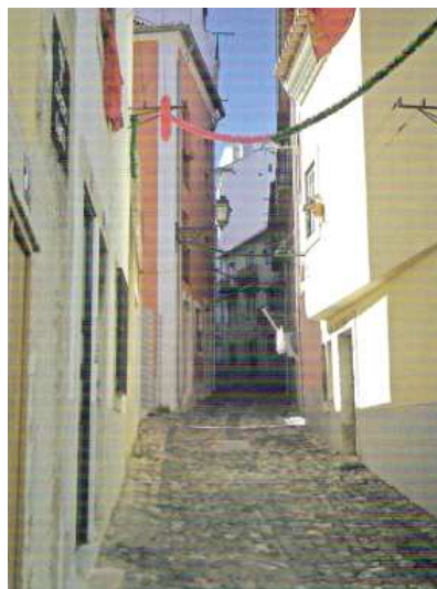
Figura 3 - Vãos que abrem para um arruamento estreito. [13]
