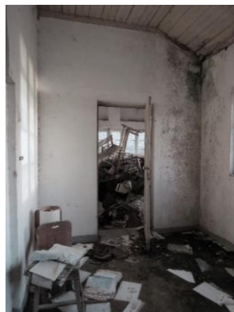
Figura 85 - Sala de arrumos Fonte: Próprio autor
