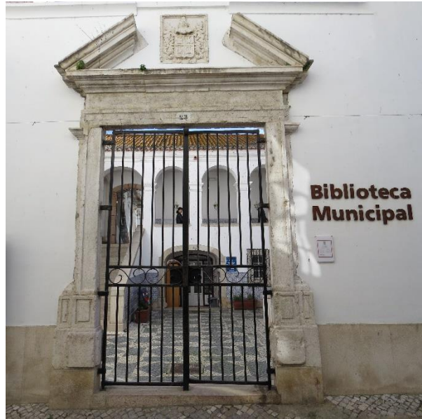
Figura 36 - Solar dos Salemas (atual Biblioteca Municipal), entrada principal Fonte: Próprio autor
