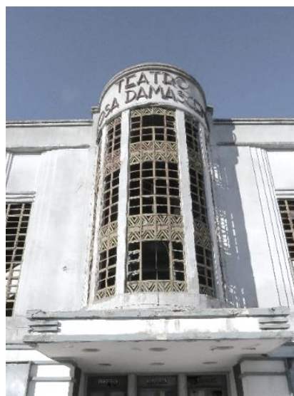
Figura 64 - Janela cilíndrica do Teatro Rosa Damasceno Fonte: Próprio autor
