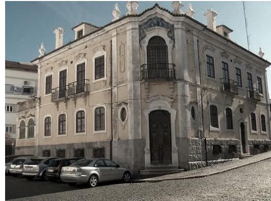
Figura 44 - Palacete para o Sr. António Palma, em Beja Fonte: Noras JR. Amílcar Pinto: Um Arquitecto Português do Século XX Volume II. Dissertação de Mestrado. Coimbra: Faculdade de Letras da Universidade de Coimbra, História de Arte; 2011. p.7.
