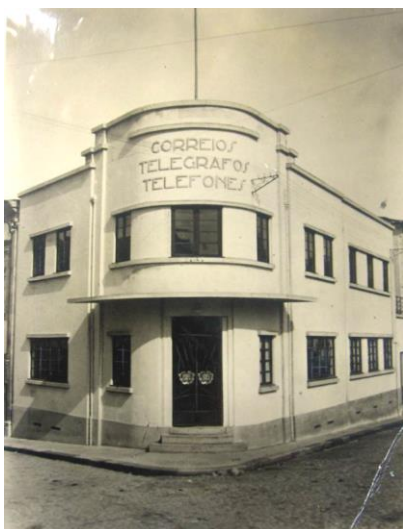
Figura 54 - Estação de Correios, Telégrafos e Telefones de Ponte de Lima
