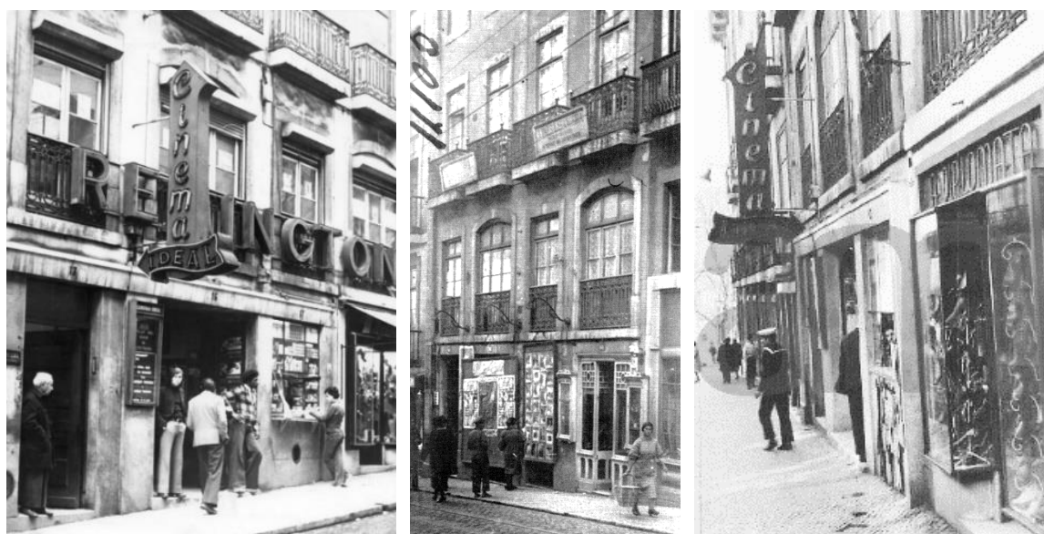
Figura 2 - Cinema Ideal na Rua do Loreto, Lisboa - vistas da fachada principal
