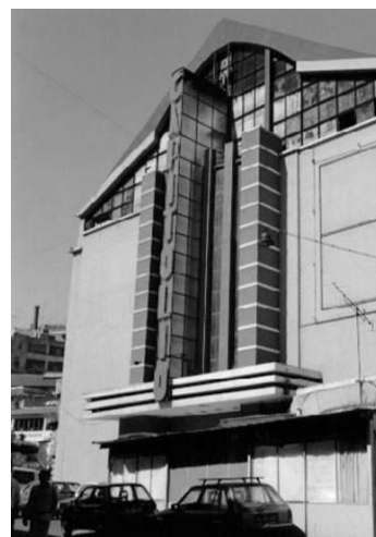
Figura 7 - Entrada Principal do Cine Teatro Capitólio (após remodelação em 1935)
