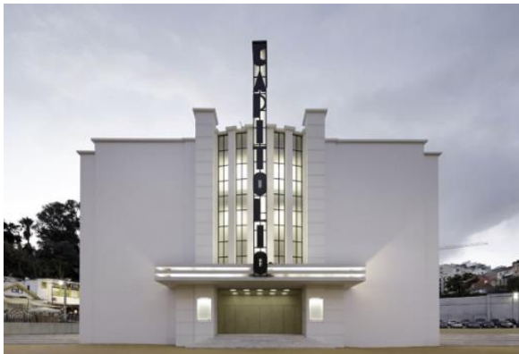
Figura 11 - Fachada Principal do Cine Teatro Capitólio, após reabilitação
