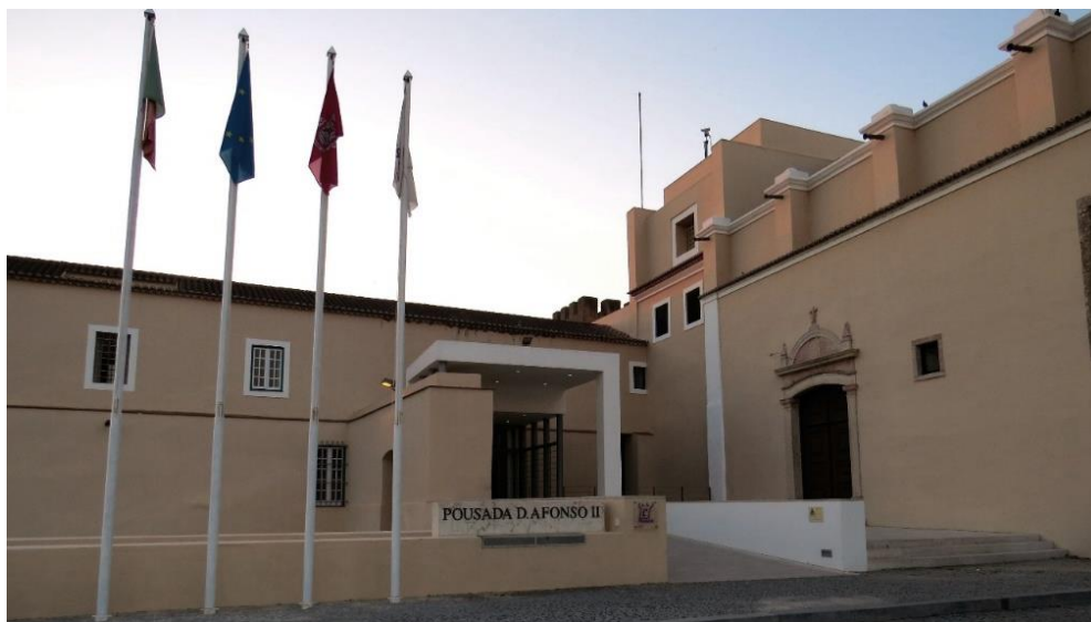
Figura 27 - Entrada para a Pousada D. Afonso II e entrada para a Igreja de Nossa Senhora de Aracoeli (entrada situada à direita na imagem)
