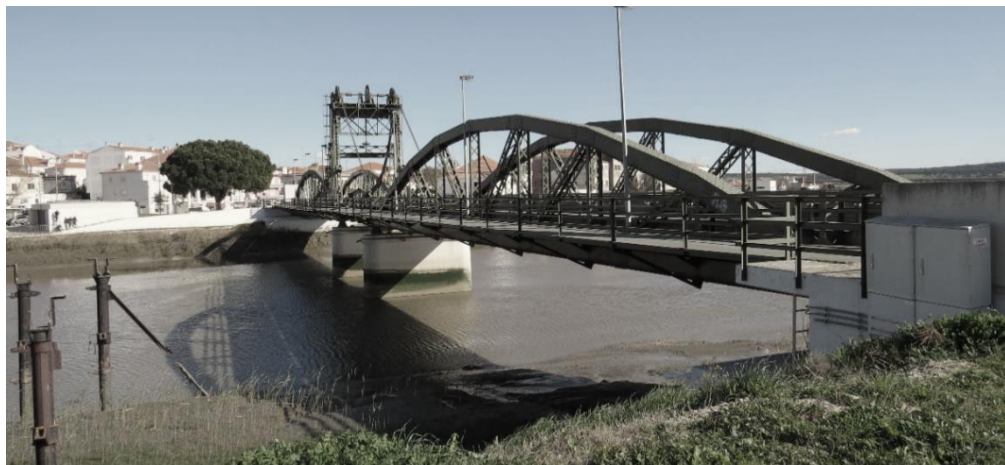
Figura 37 - Ponte Metálica Fonte: Próprio autor
