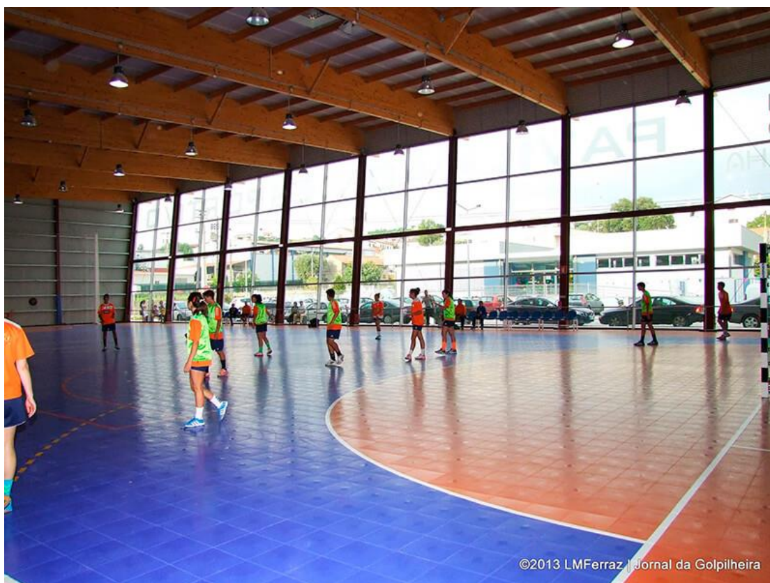
Figura 12 - Iluminação natural através de uma das paredes do Pavilhão da Golpilheira
