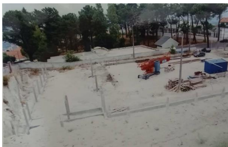
Figura 22 – Início da fase de obras do pavilhão do GDM
