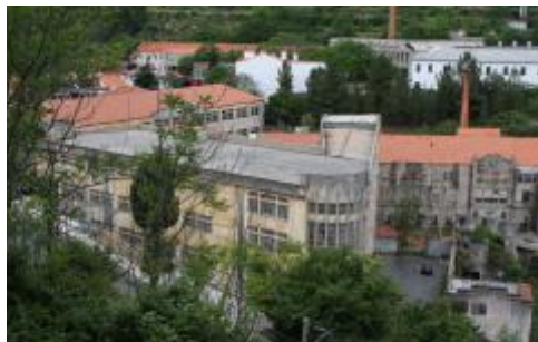
Fig.65 Vista sobre a Edificação.
