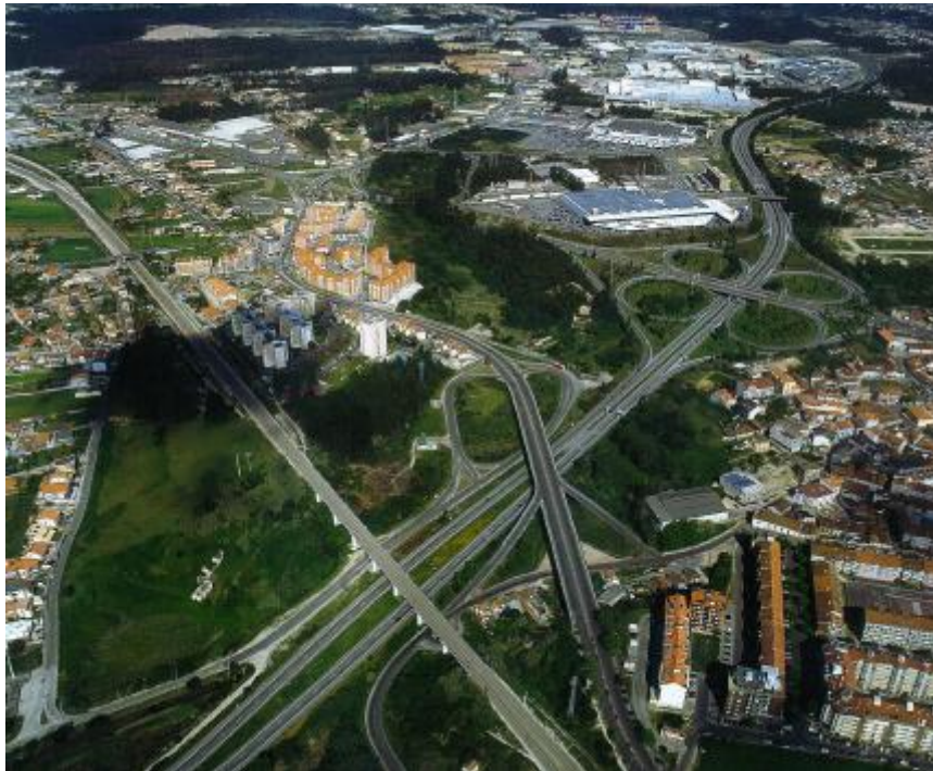
Fig.9 Vista sobre as infra-estruturas rodoviárias.
