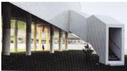
Fig.25 Vista do novo volume.
