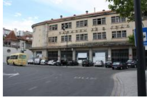
Fig.72 Vista frontal do edifício.
