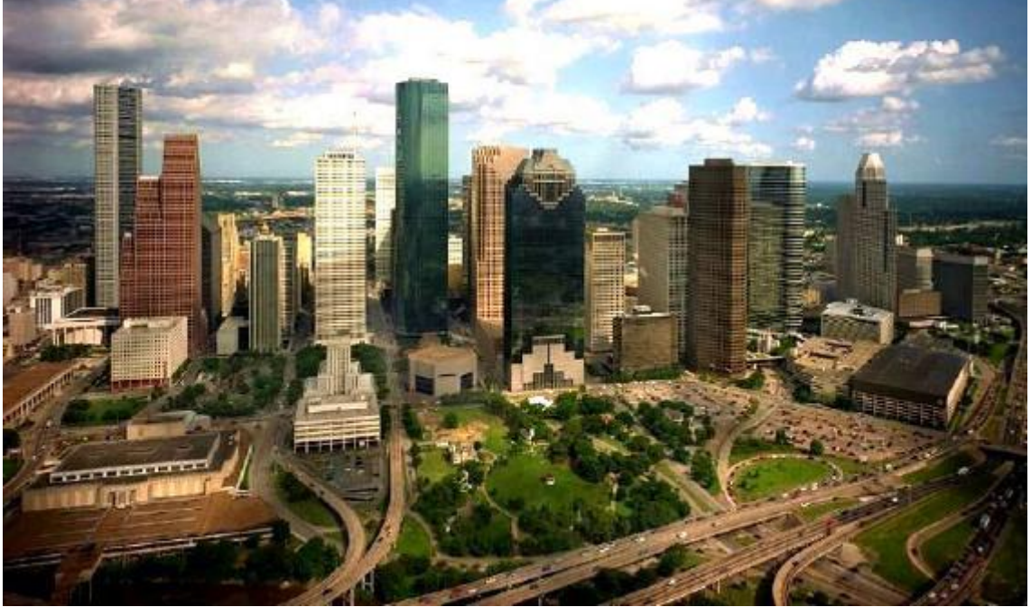
Fig.4 Construção em altura na cidade de Houston, Texas.
