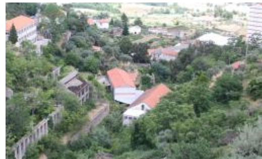
Fig.60 Edifícios junto à ribeira.
