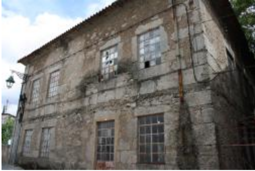
Fig.79 Estrutura em alvenaria de pedra.
