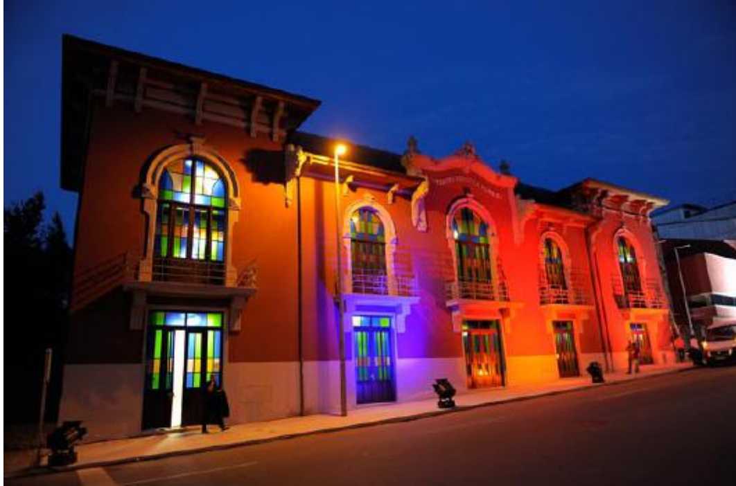
Fig.32 Casa das Artes de Felgueiras.
