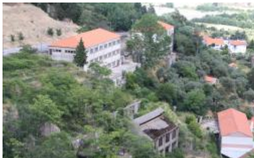
Fig.59 Edifício de cota superior.
