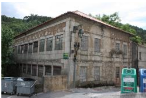
Fig.77 Edifício de intervenção.
