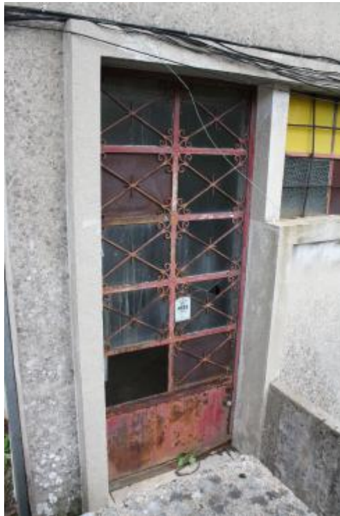
Fig.63 Porta do edifício de cota superior.
