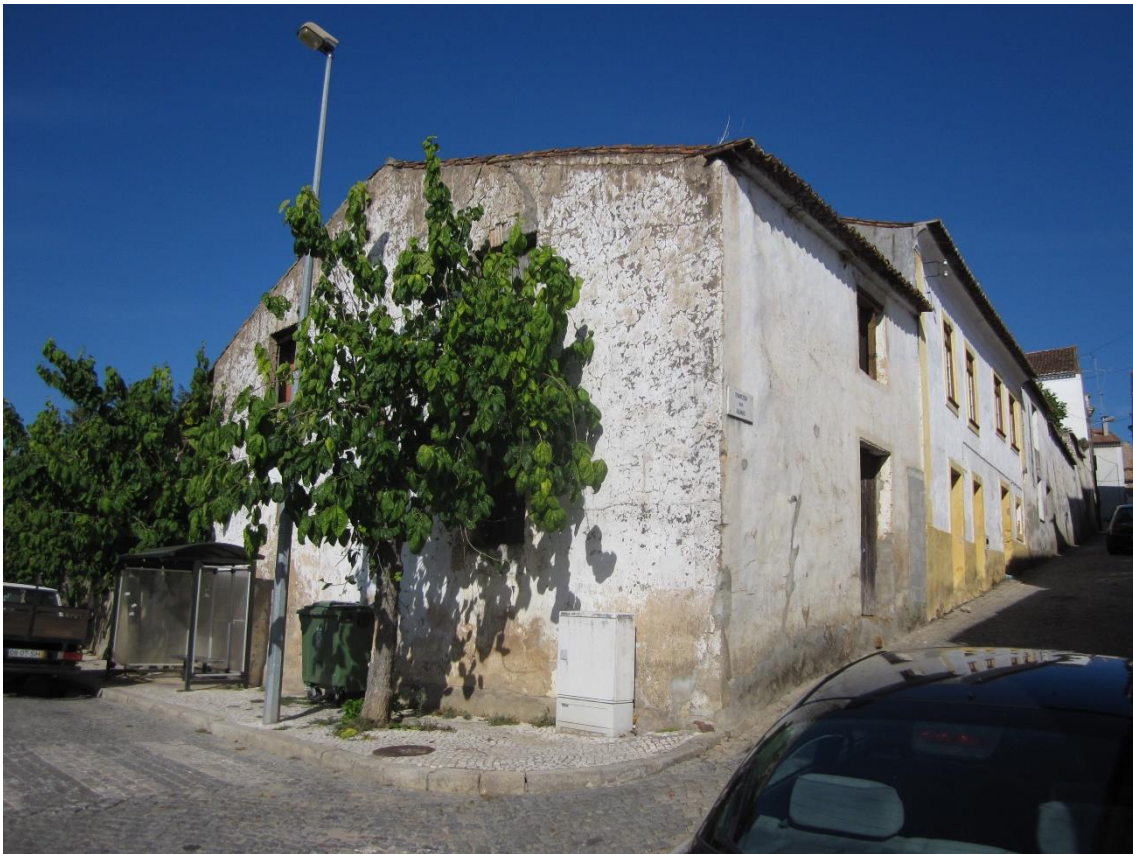
Figura 49 - Fachada do último edifício do conjunto.
