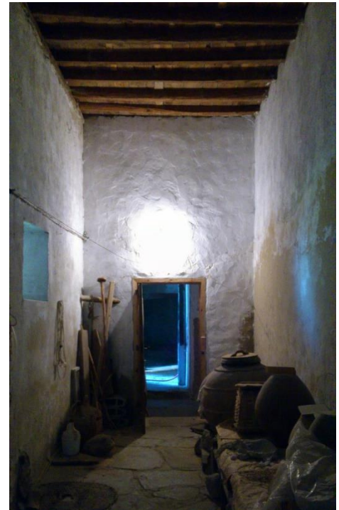
Figura 41 – Corredor lateral casa Pina Falcão.
