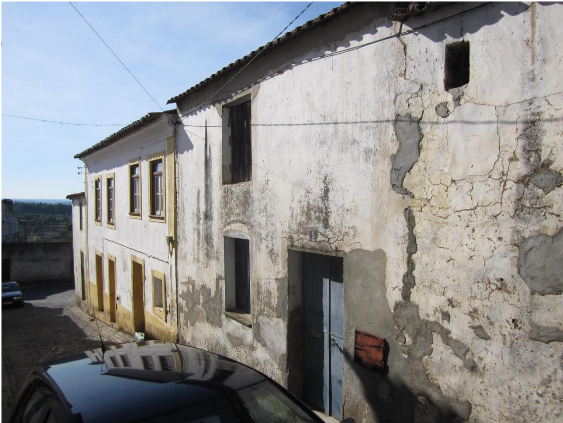
Figura 45 - Fachada do edifício a Norte.
