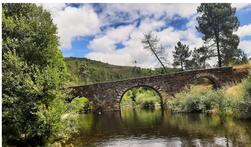
Figura 12 - Ponte da Isna.
