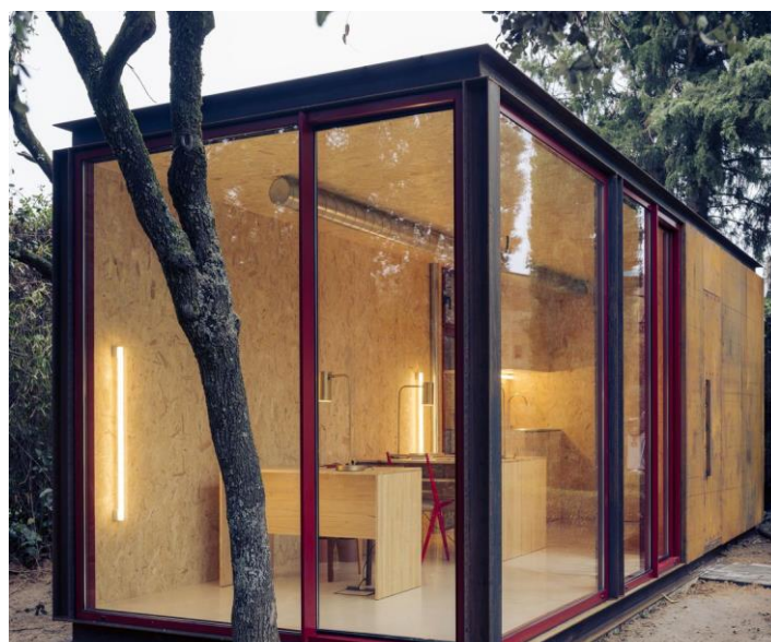
Figura 31 – Estrutura pré-fabricada do estúdio delavegacanolasso.
