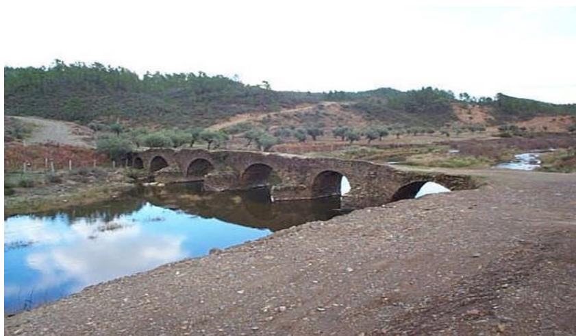
Figura 11 - Ponte da Ladeira em Envendos.
