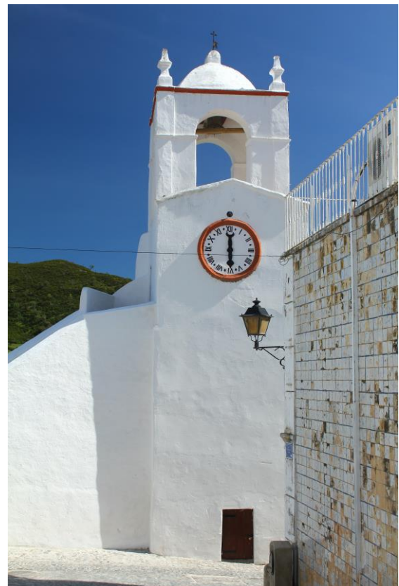
Figura 51 _ Torre do Relógio
