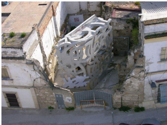
Figura 15 _ Betão Perfurado e transformado in situ
