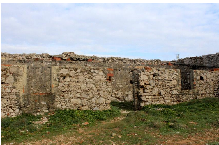
Figura 33 | Ruínas do compartimento de alojamento no local de intervenção
