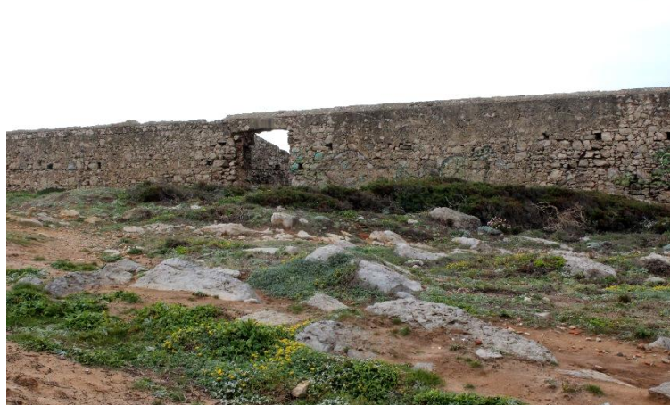
Figura 24 | Fachada principal do local de intervenção
