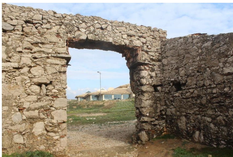
Figura 36 | Acesso principal do local de intervenção
