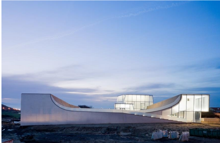
Figura 16 | Vista exterior do Museu do oceano e do surf
