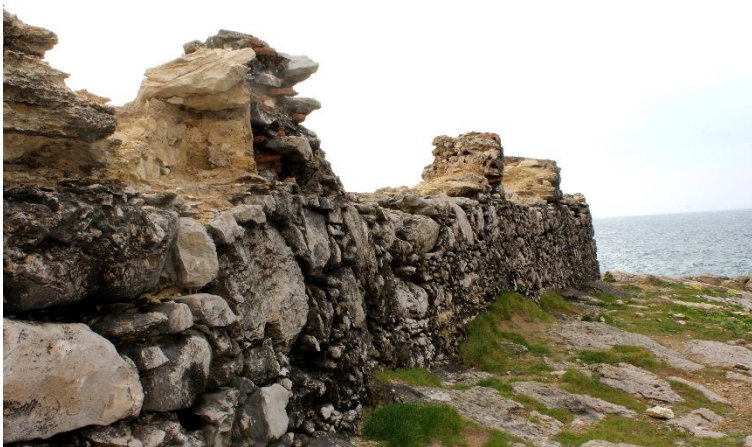
Figura 31 | Pormenor da fachada do local de intervenção
