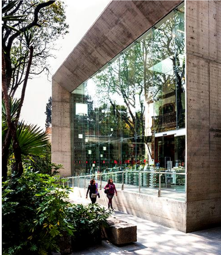
Figura 2 | Fachada principal do Centro Cultural Elena Garro
