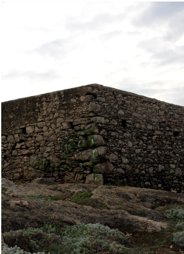
Figura 26 | Pormenor na fachada do local de intervenção
