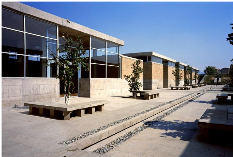
Figura 9 | Fachada do refeitório e das oficinas do Centro para invisuais e deficientes visuais
