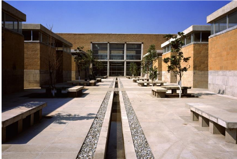
Figura 8 | Fachada Principal do Centro para invisuais e deficientes visuais
