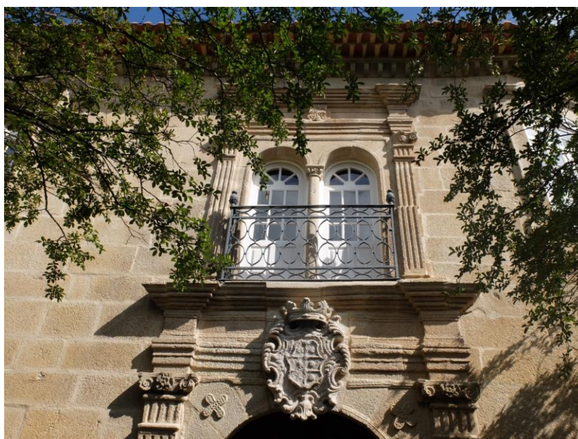
Figura 14 - Casa do Miradouro, instalação da SRU Viseu Novo; detalhe de brasão e janela
