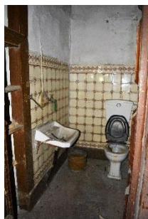
Figura 96 - Instalação sanitária de serviço
