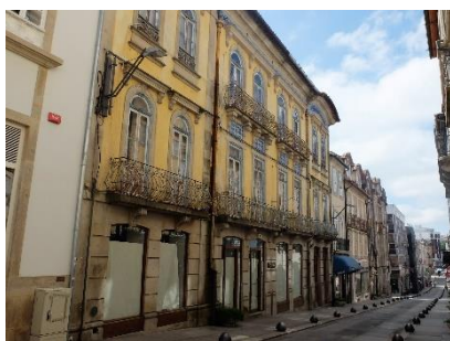
Figura 67 - Fachada Principal, Rua do Comércio
