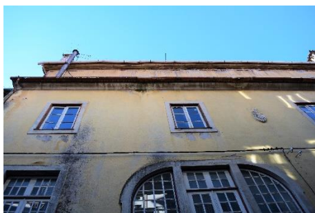
Figura 73 - Fachada Posterior; vários tipos de vãos
