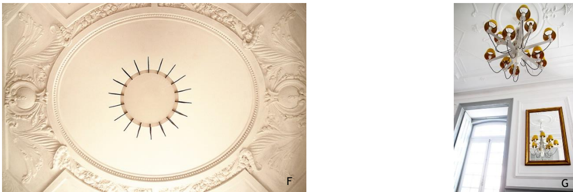
Figura 44 - F - Pormenor do teto de estuque trabalhado; G - Detalhe de candelabro com cor forte
