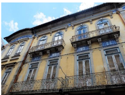
Figura 62 - Fachada Principal (Rua Dr. Luís Ferreira)
