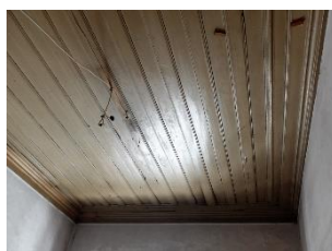
Figura 104 - Teto revestido em madeira
