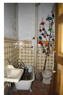
Figura 111 - Instalação sanitária - piso 2
