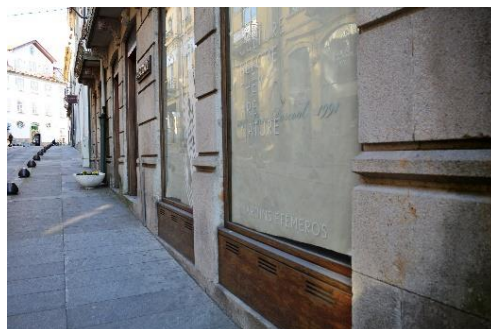
Figura 64 - Pormenor da pedra na fachada e vãos do piso térreo
