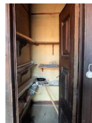
Figura 118 - Dispensa da cozinha
