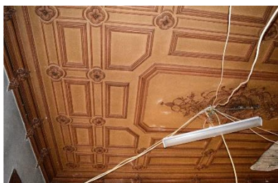
Figura 9 - Detalhe do teto, estuque trabalho pintado de castanho
