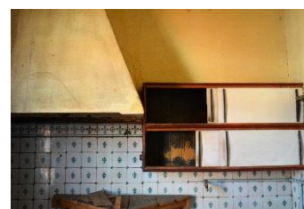
Figura 114 - Detalhe da chaminé e pequeno armário
