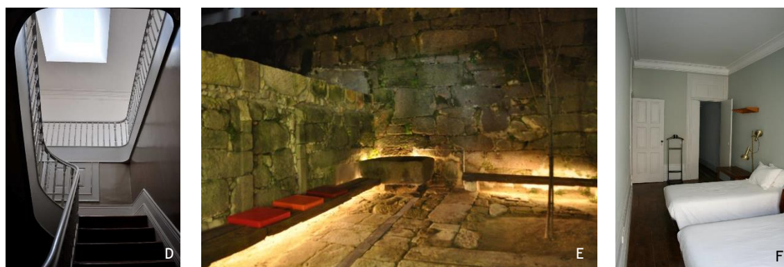
Figura 59 - D - Detalhe da escadaria principal; E - Espaço de logradouro; F - Quarto Partilhado
