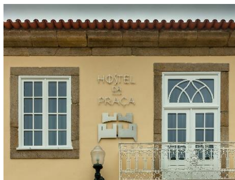
Figura 49 - Pormenor da Fachada Principal
