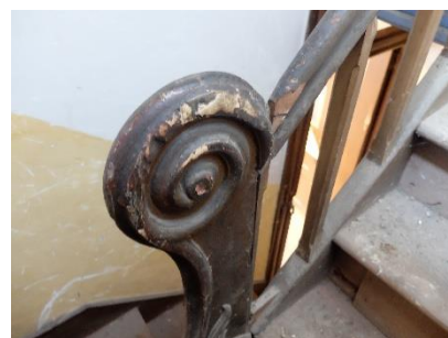
Figura 121 - Detalhe da guarda de proteção
