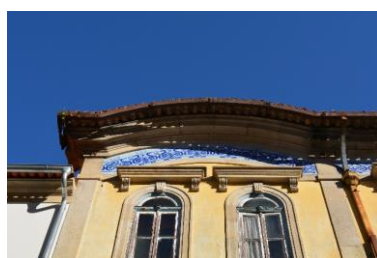
Figura 71 - Terminação da lateral do edifício
