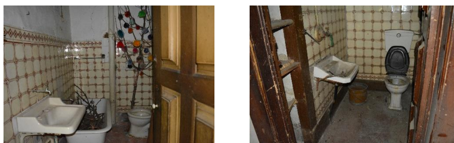
Figura 156 - Instalações sanitárias do piso 1 e piso 2
