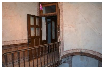
Figura 101 - Acesso para o sótão e o corredor
