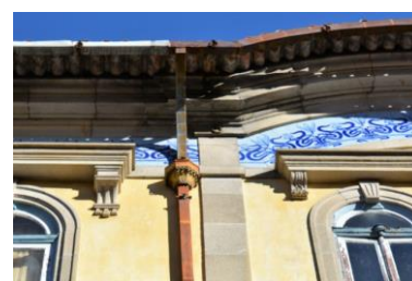
Figura 72 - Pormenor do tubo de queda de água; dos frontões e do friso de azulejos
