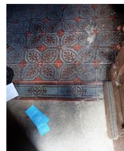
Figura 82 - Pavimento do hall de entrada
