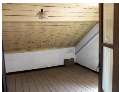
Figura 124 - Compartimento em bom estado de conservação
