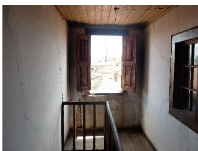
Figura 125 - Detalhe de janela para o exterior e outra para o interior
