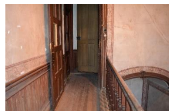
Figura 102 - Acesso ao sótão
