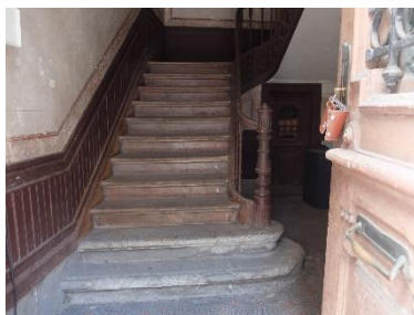
Figura 153 - Escadas de acesso à habitação
