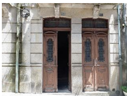
Figura 65 - Portas de acesso à habitação (nº 92 e 94)
