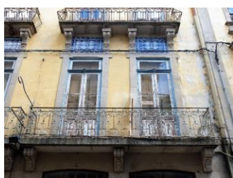
Figura 70 - Pormenor dos azulejos azuis e brancos
