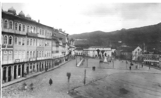
fig. 30 - Terreiro de S. Sebastião, após a demolição da igreja, ainda se vê as marcas sua implantação -1896
