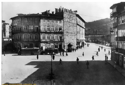
fig. 24 -Toural em direcção a torre da alfandega, antes das demolições dos edifícios da direita
