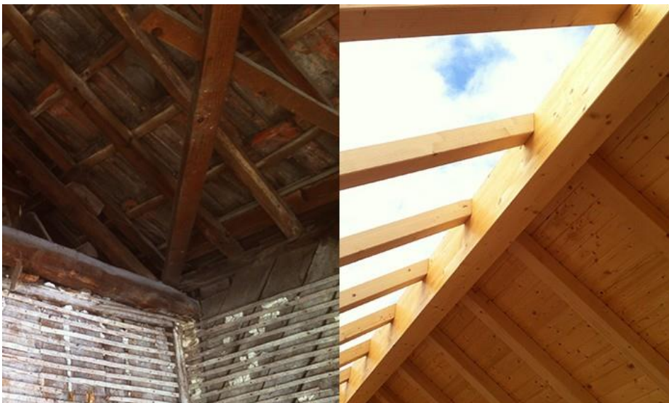
Figura 3.3 – Reconstrução de estrutura de cobertura
