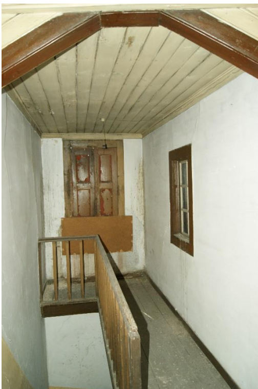
DO1 – Agua furtadas escadas de acesso
