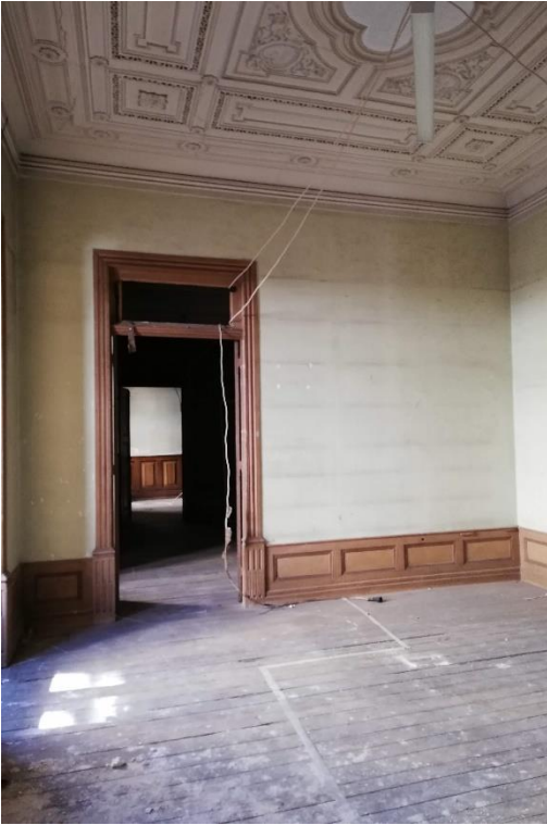
Bo5 – Vista geral de sala
