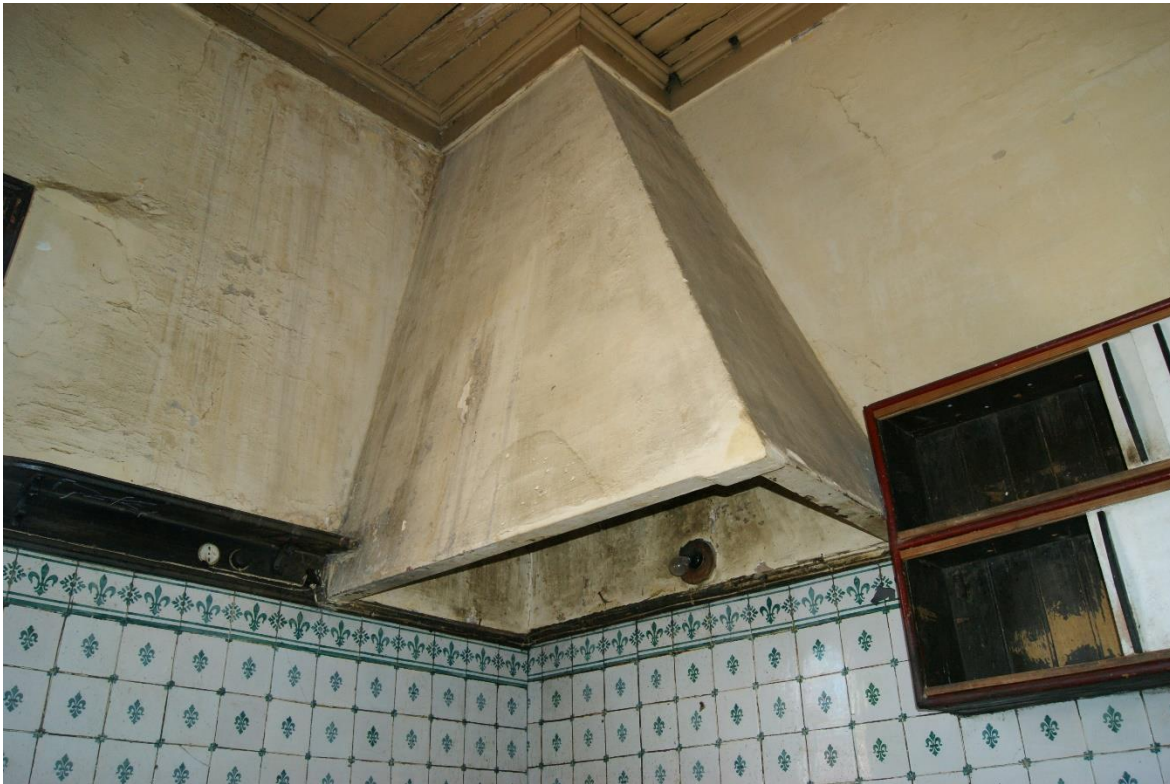
C20 – Chaminé de cozinha
