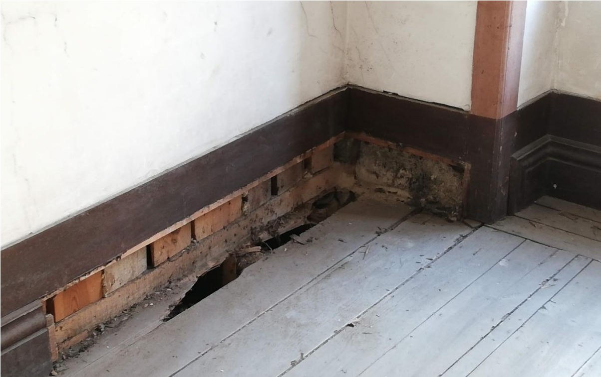
B27 – Pormenor de parede de frontal - sondagem
