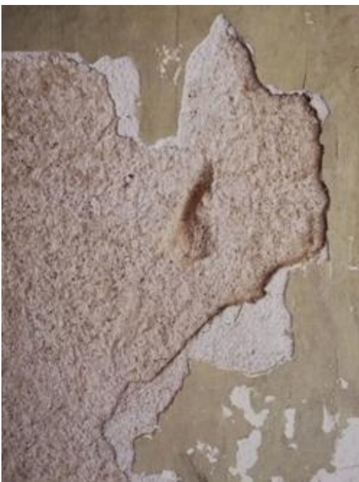
Figura 1.3 – Sondagem em parede
