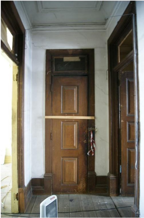
B29 – Desnível no corredor
