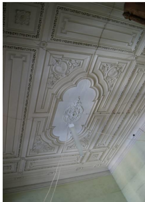
Figura 1.4 – Pormenor de teto em estuque
