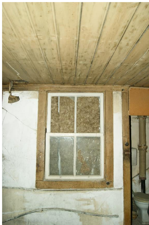
Do8 – Janelas fechada e instalações
