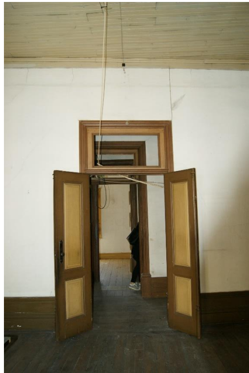
Co9 – Vista entre salas
