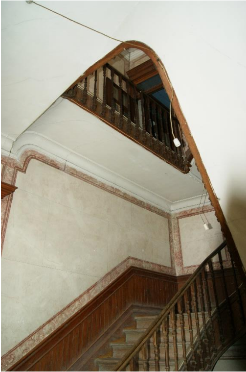
A05 – Vista da escadaria
