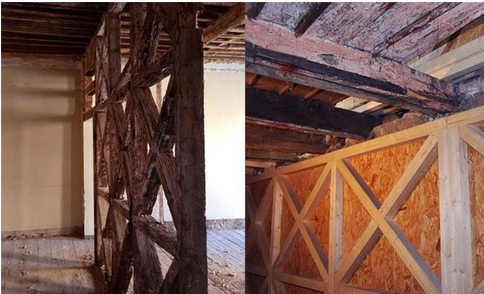
Figura 3.2 – Reconstrução de parede de tabique
