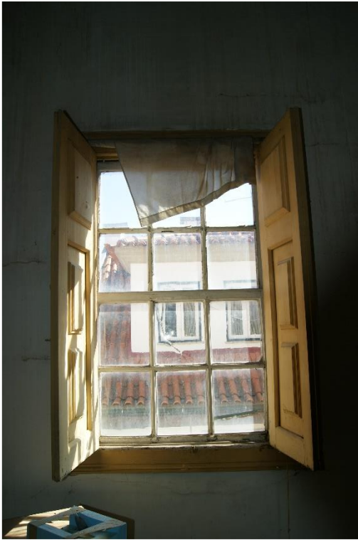
C12 – Pormenor de janela
