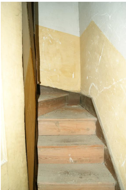
C23 – Escada estreita
