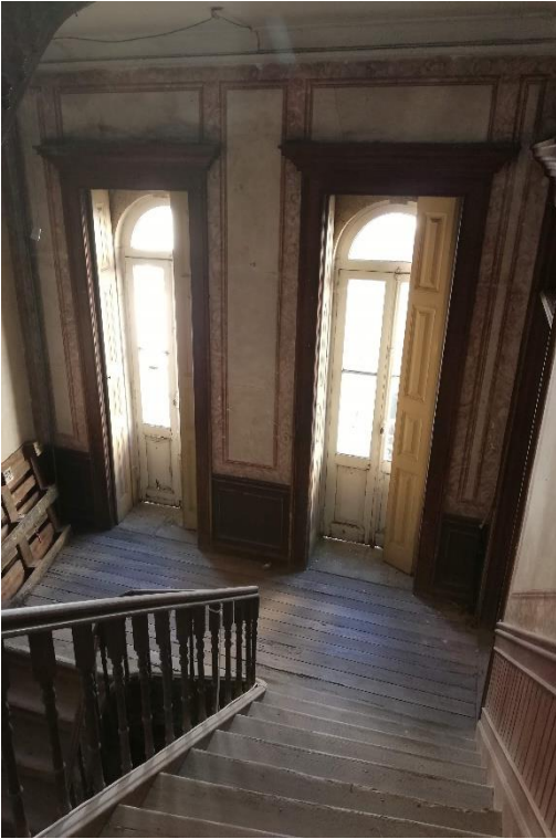
Co1 – Vista da entrada
