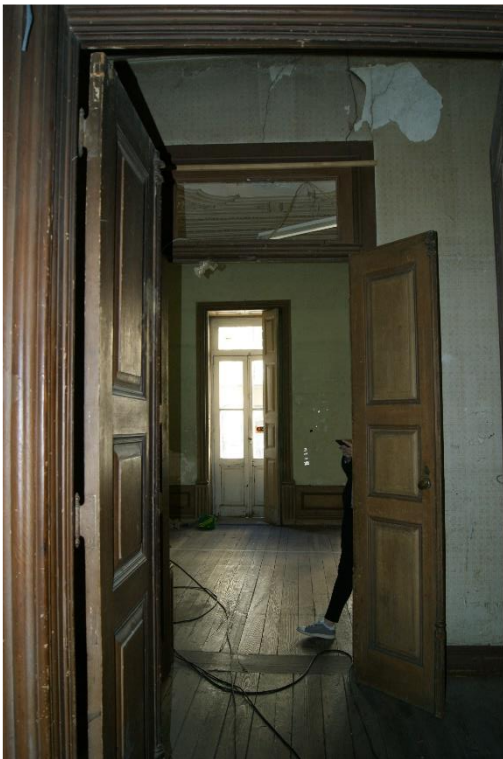
B31 – Vista entre salas
