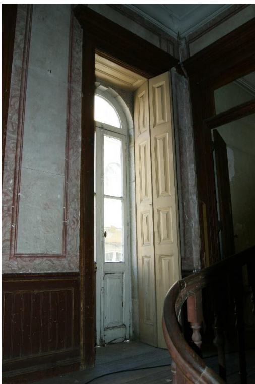
Bo1 – Caixilharia e portadas interiores
