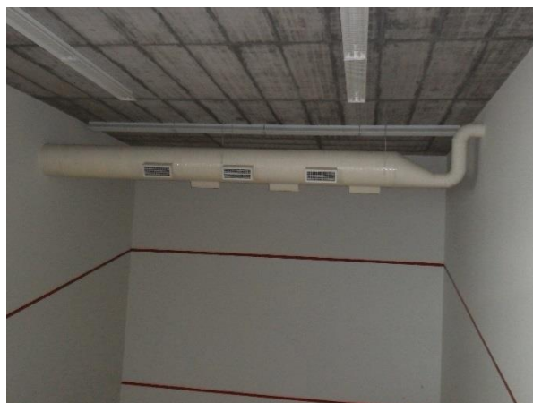
Figura 5 - Grelhas de insuflação e extração em um dos dois campos de squash.
