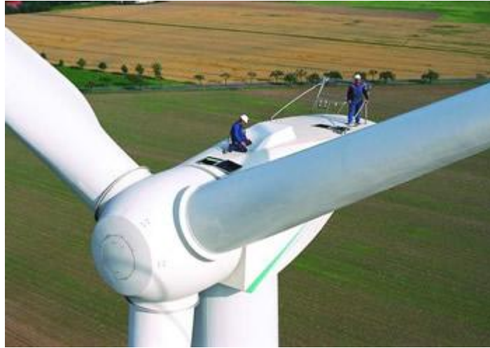
Figura 1 - Exemplo de uma torre eólica.
