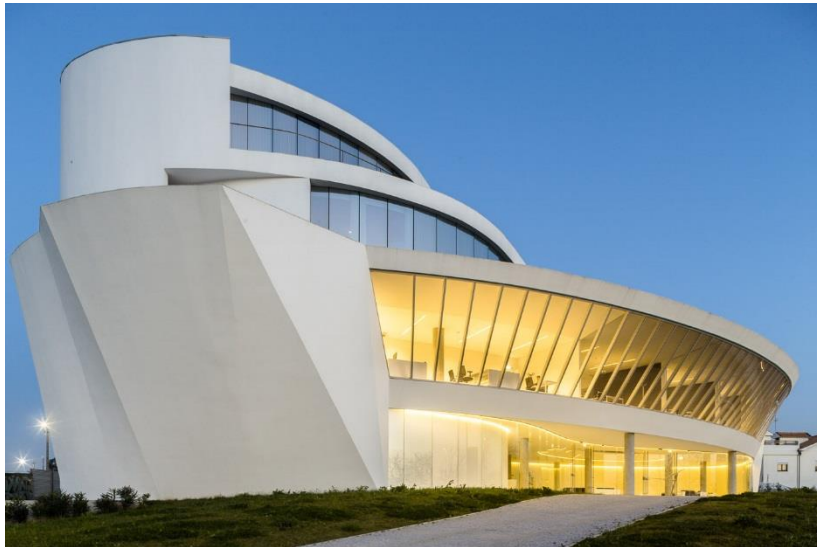
Figura 1.1 Centro de Engenharia do CEiiA, [4].
