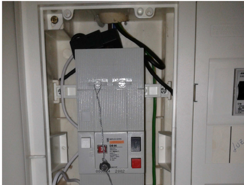
Figura 4.22 – Montagem do sensor em torno do cabo sob tensão.
