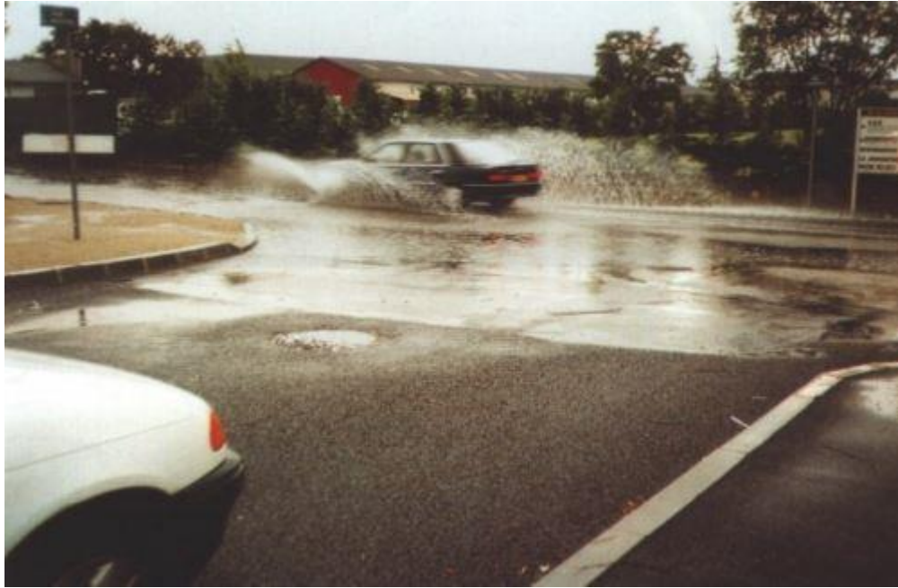
Figura 3.3 - Diferença entre o comportamento de um pavimento poroso e de um tradicional (Matos, 2000)
