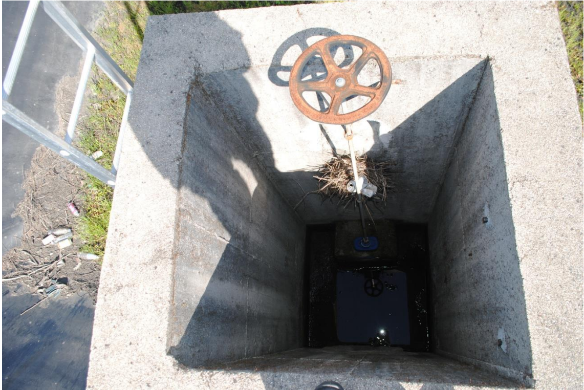
Figura 4.11 - Poço de saída da bacia 3
