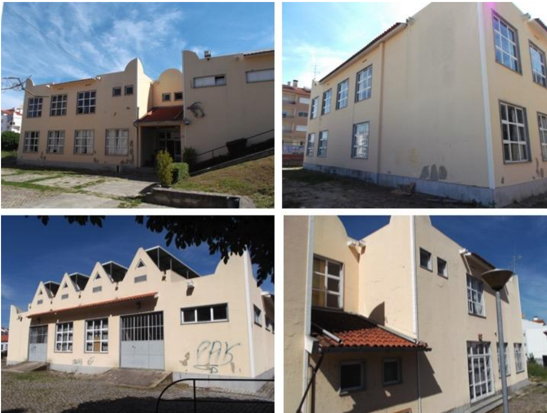
Figura 30. Fotografia das diferentes fachadas do edifício das artes do Agrupamento de Escolas do Fundão, escolhida pelos alunos como local para a criação da obra de Arte Urbana em Contexto Escolar.
