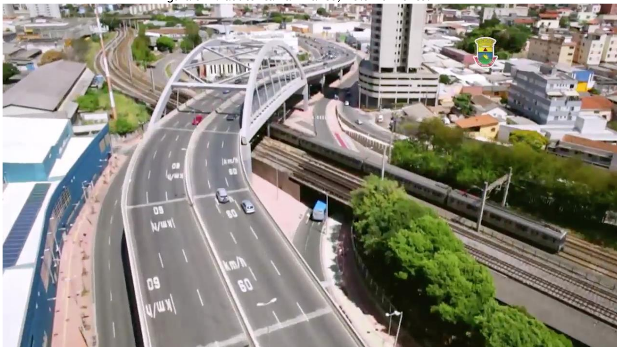
Figura 5 - Viaduto Itamar Franco, Belo Horizonte.
