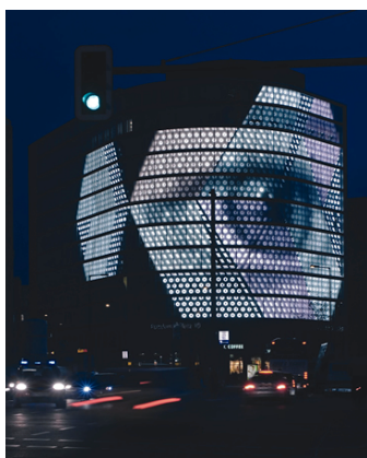
Fig.3.39 Edifício Spots, Estúdio Realities
