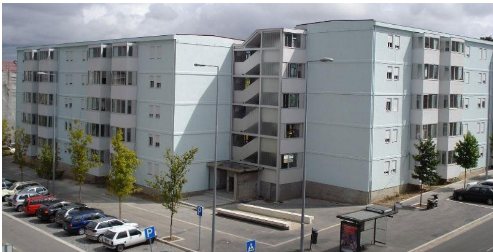
Figura 24 - Bairro do Contumil - reabilitação do acesso vertical. Fonte: www.cari.pt (última consulta em: 22-07-2016).
