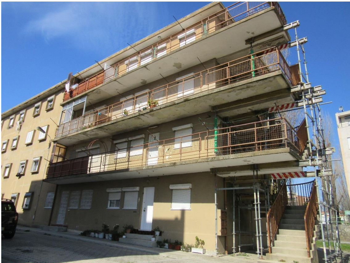
Figura 52 - Galerias Horizontais. Fonte: Imagem da autora.
