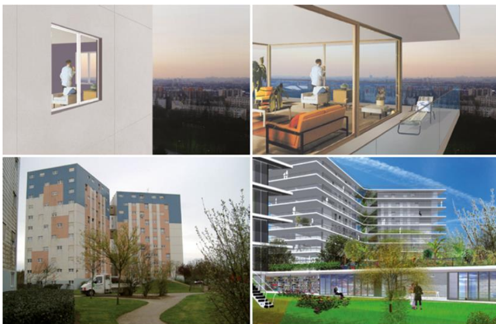
Figura 32 - Conjunto de imagens, de exterior, demonstrativas do estudo “PLUS - Les grands ensembles de logements Territoire d exception” de Druot, Lacaton & Vassal. Fonte: www.lacatonvassal.com/publications.php (última consulta em 22-07-2016).
