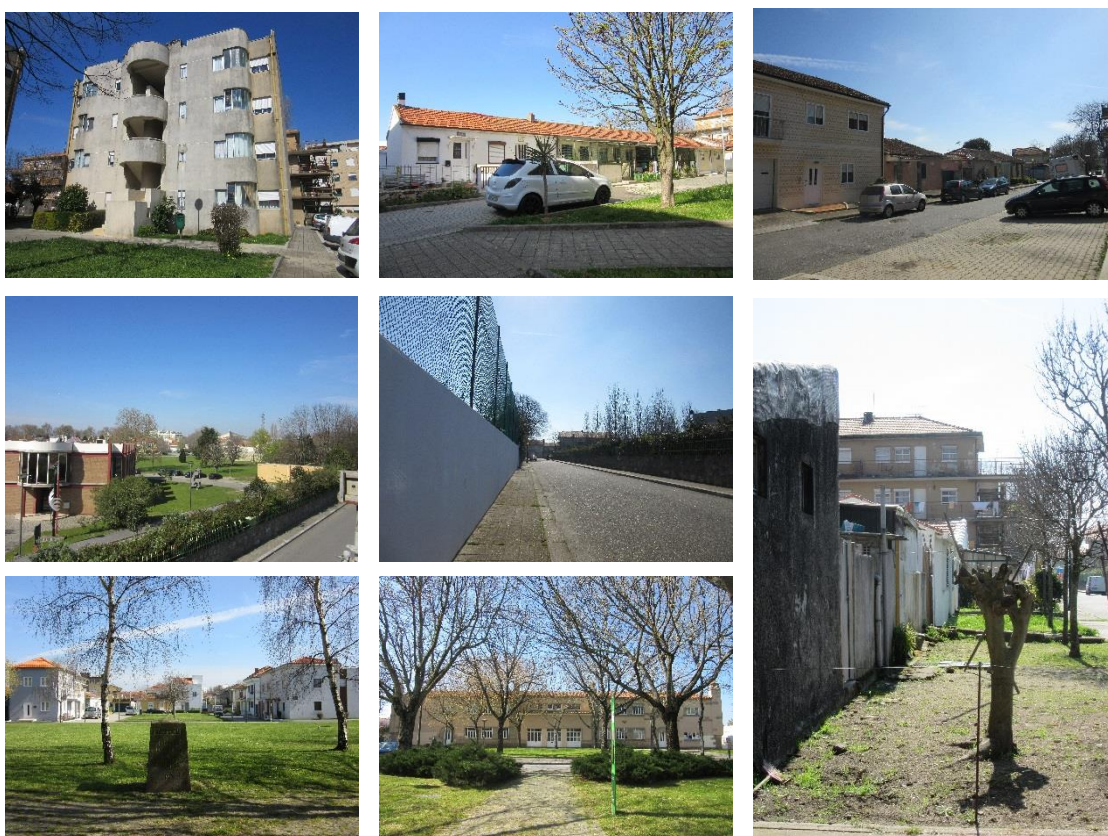
Figura 45 - Levantamento fotográfico da envolvente. 1- Edifício do bairro dos Choupos, 2- Casas dos pobres, 3- Habitação térrea envolvente, 4- Área empresarial anexa a norte da implantação do bairro, 5- Rua dos Plátanos, sentido do ringue desportivo, 6- Agrupamento de moradias económicas de Ramalde, 7- Escola primária, 8- Perspetiva do alçado das casas dos pobres na rua dos Plátanos. Fonte: Imagens da autora.
