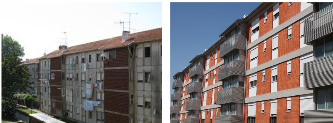
Figura 21 - Bairro Lagarteiro, (esq.) antes e (dir.) após a reabilitação. Fonte: www.jpn.up.pt/wp-content/uploads/2014/12/lagarteiro_cimento.jpg ; www.domussocial.pt/habitacoes/bairro-do-lagarteiro_2 (última consulta em: 22-07-2016).
