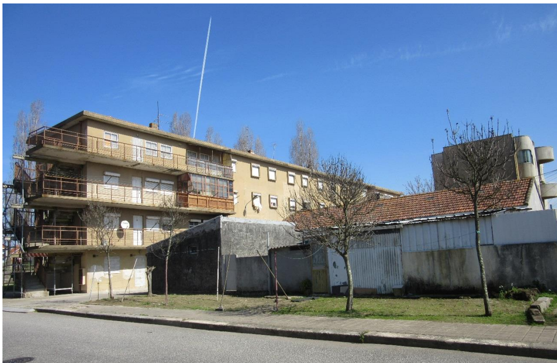
Figura 48 - Bloco A, vista pela Rua dos Plátanos. Fonte: Imagem da autora.
