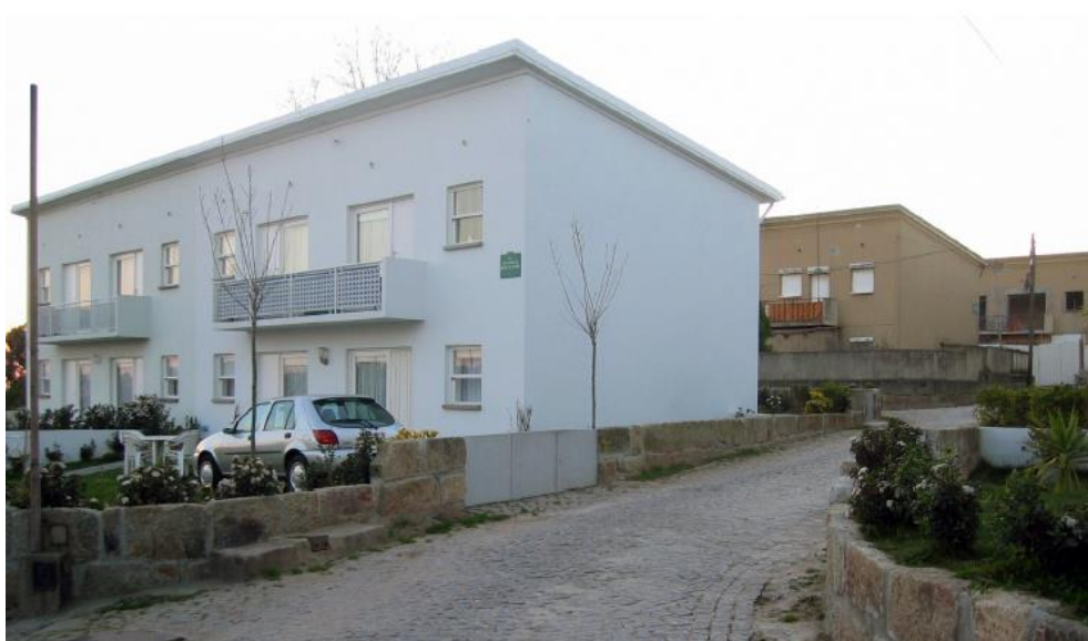
Figura 27 - Bairro Rainha D.Leonor (1ª fase), casa reabilitada em primeiro plano e casas originais em plano de fundo. Fonte: Restivo, 2014.
