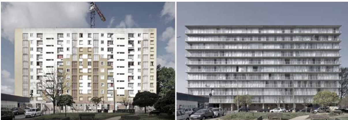
Fig. 25 - Transformação de 530 Unidades Habitacionais, (Antes e depois da intervenção), Christophe Hutin Architecture, Frédéric Druot e Lacaton & Vassal
