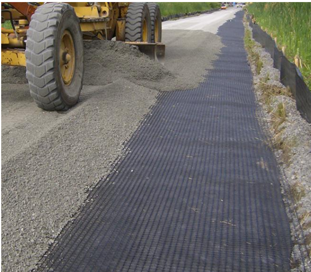
Figura 1.3. Utilização com a função de estabilização.
