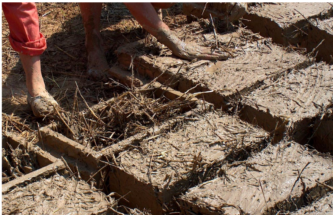
Figura 2.8: Moldagem de Adobe
