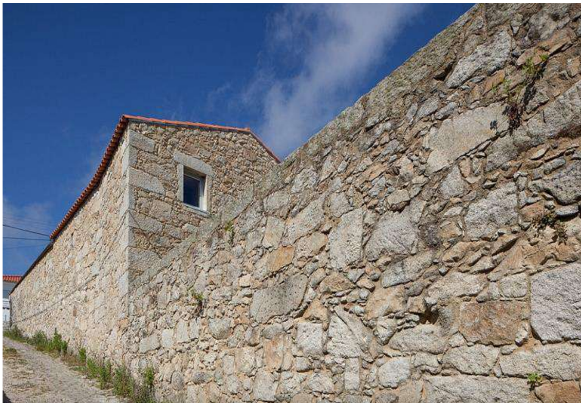
Figura 3.6: Fachada cega - Casa das Nogueiras
