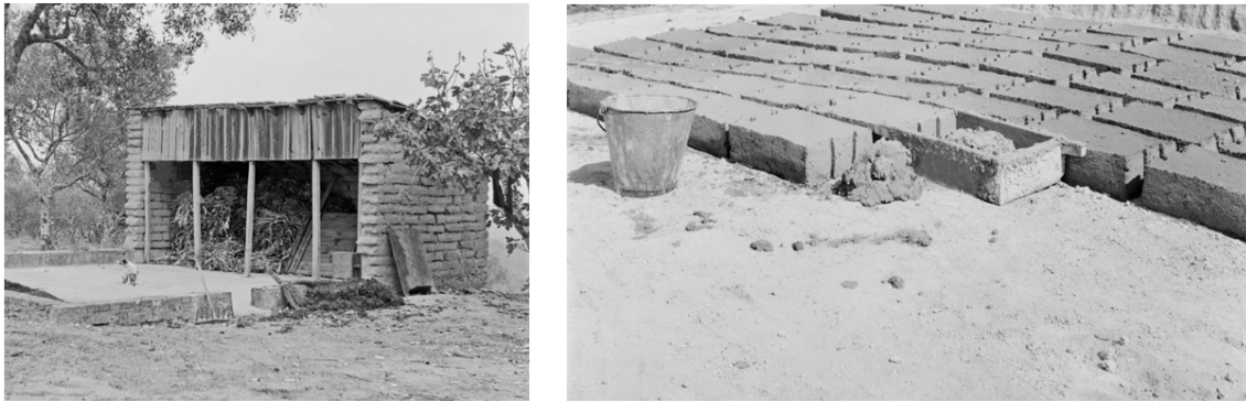
Figura 2.62: Palheiro de adobe e eira - Leiria (Esq.) e Estaleiro de Adobe - Rio Maior (Dir.)
