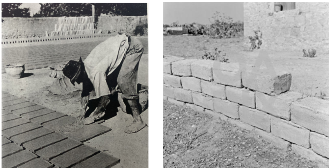
Figura 2.90: Execução de Tijoleira - Loulé (Esq.) e Blocos de Adobe - Albufeira (Dir.)
