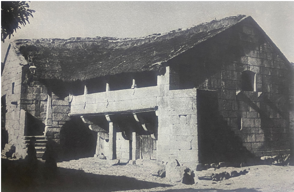
Figura 2.34: Cobertura em colmo, Trás-os -Montes
