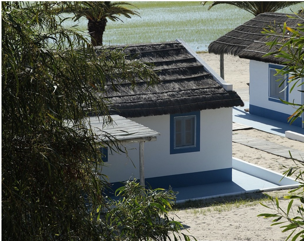
Figura 2.78: Cobertura em Colmo - Casa Mosquitos - Comporta
