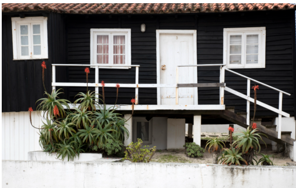
Figura 2.58: Habitação sobre estacas - Praia da Tocha
