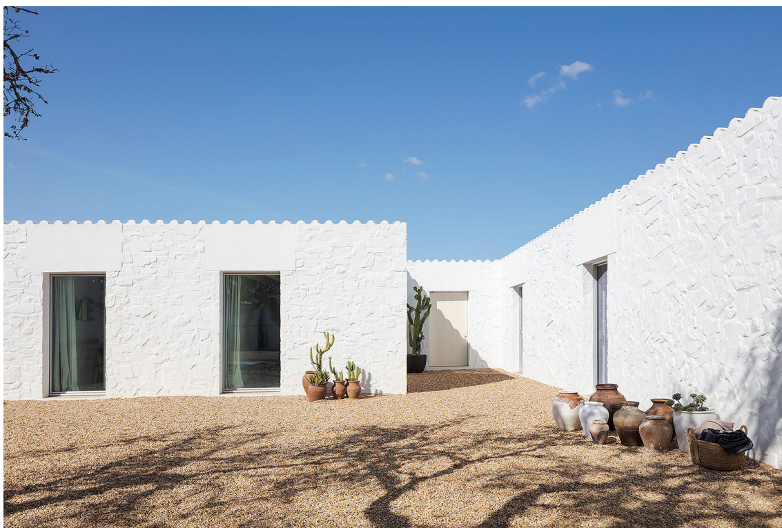
Figura 3.34: Paredes Exteriores em Alvenaria de Pedra Caiada de Branco - Casa da Volta
