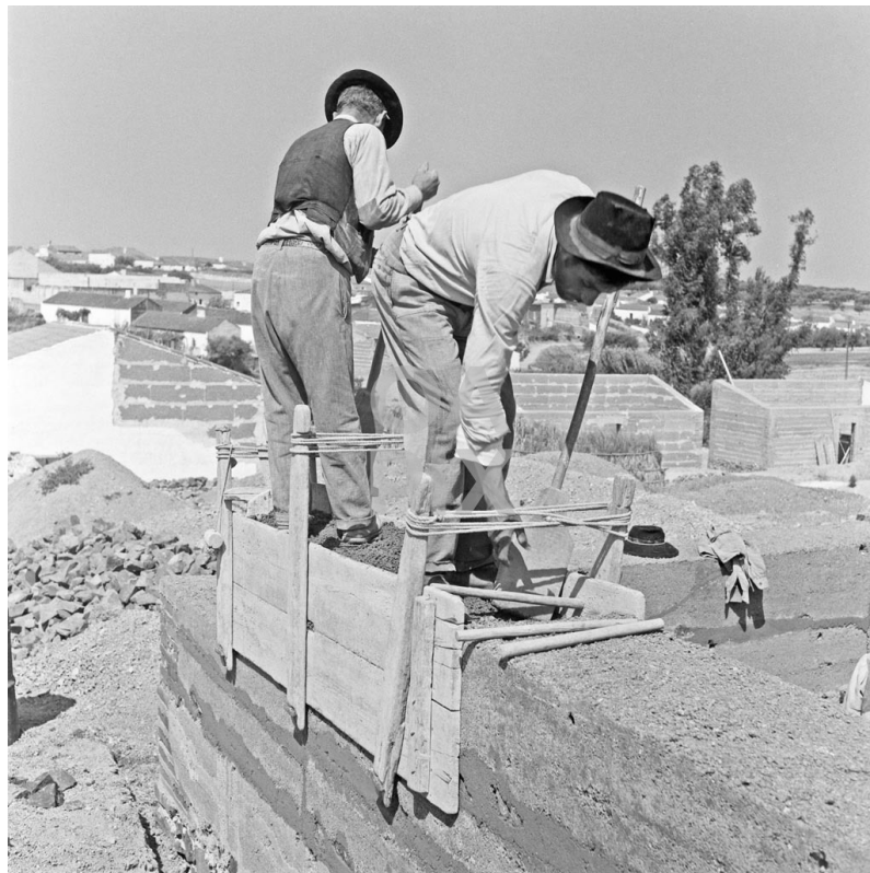
Figura 2.75: Execução Perede em Taipa - Ferreira do Alentejo
