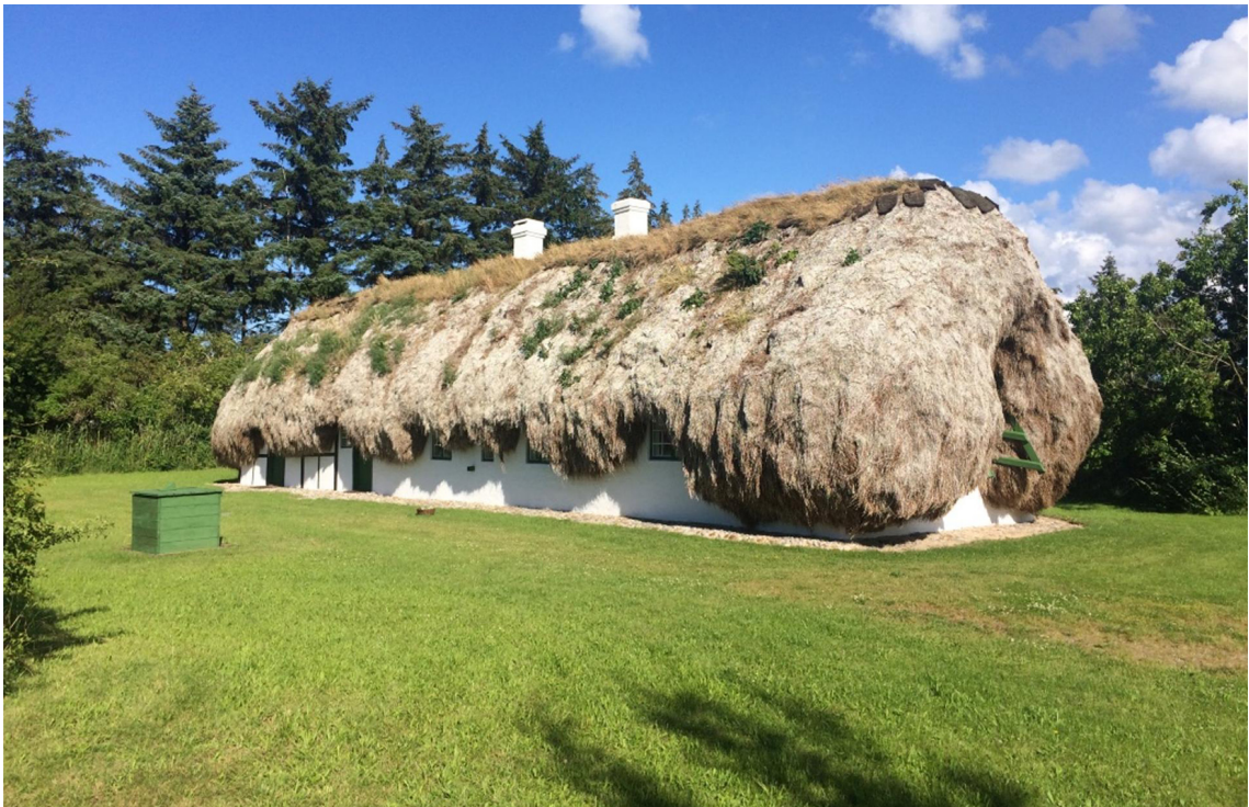
Figura 2.7: Cobertura desenvolvida com algas marinhas - Ilhas Læsø
