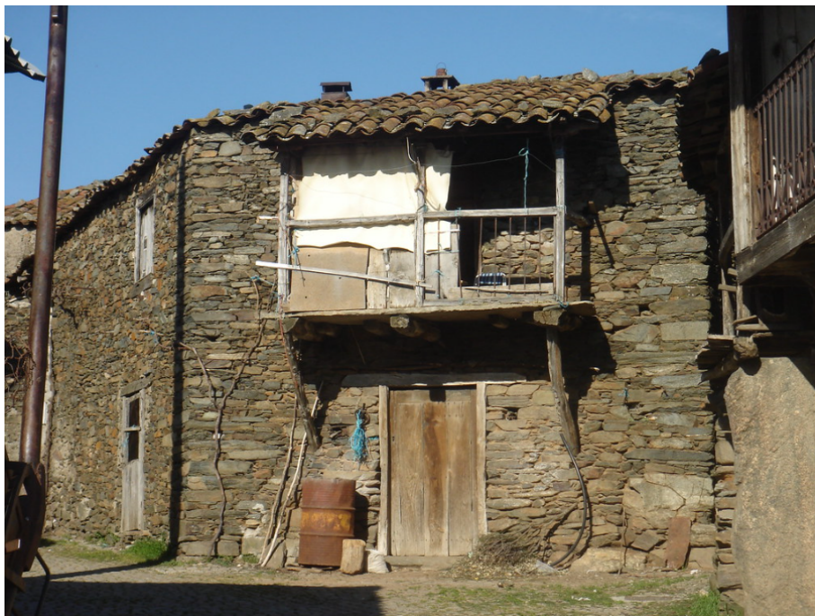
Figura 2.27: Varandas Trás-os-Montes - Viduedo
