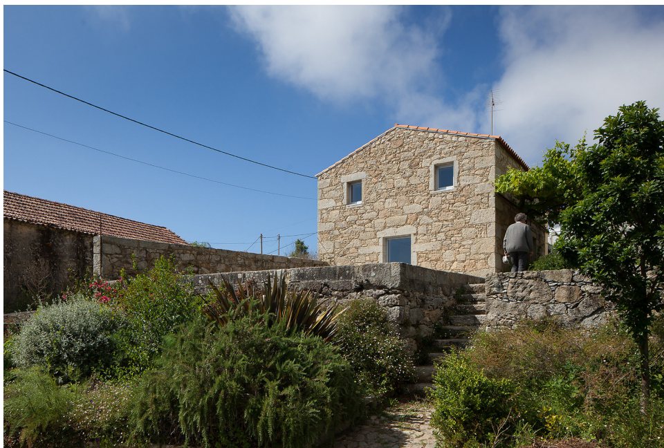
Figura 3.1: Paredes Perimetrais Existentes - Casa das Nogueiras
