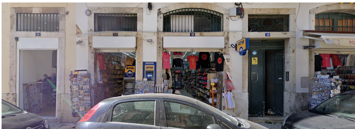
Figura 2.55: Padieira com promoção ventilação - Alfama
