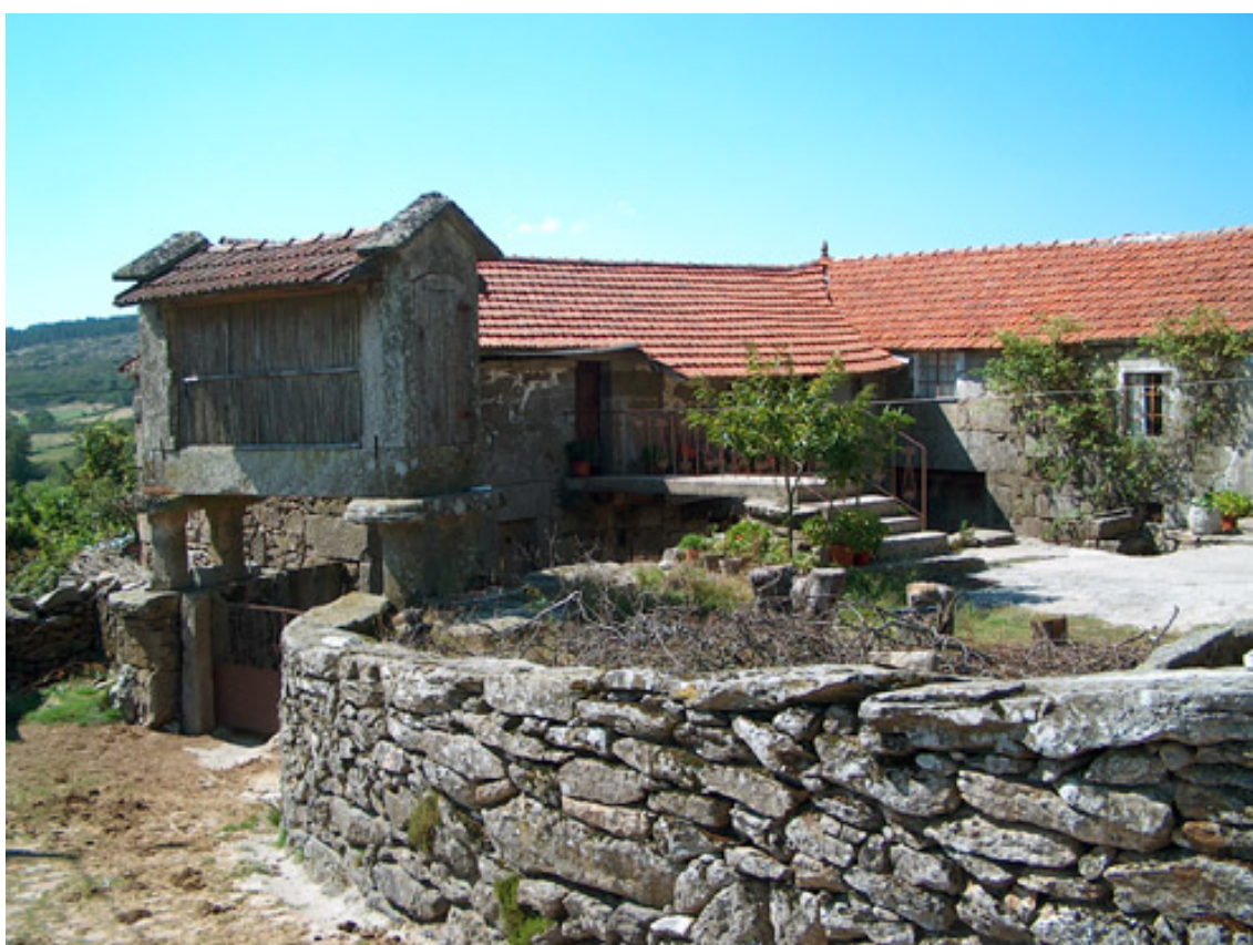
Figura 2.15: Esigueiros de Sequerio - Casa da Cabreira - Travassos
