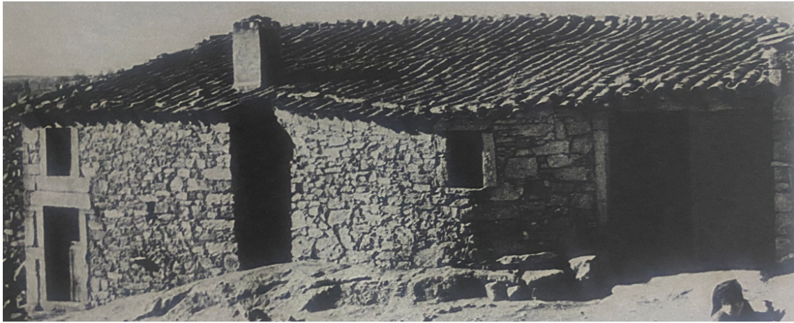
Figura 2.33: Casa em telha e Granito, Pova - Miranda do Douro
