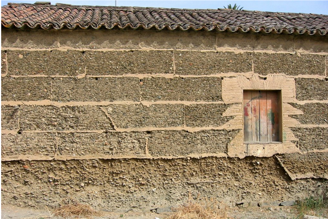
Figura 2.74: Construção em Taipa - Mértola, Alentejo
