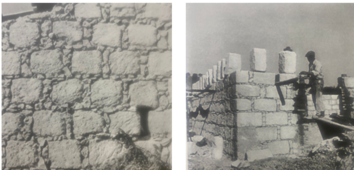
Figura 2.61: Alvenaria Desenvolvida em Tufo - Santarém
