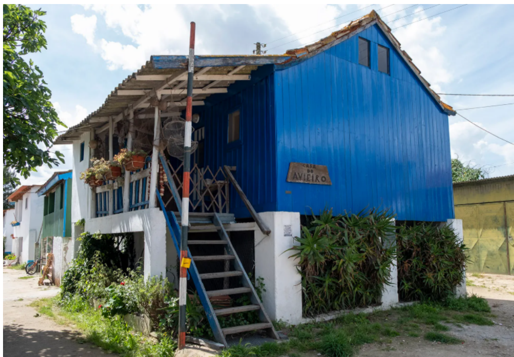
Figura 2.57: Habitação sobre estacas - Palhota, Cartaxo
