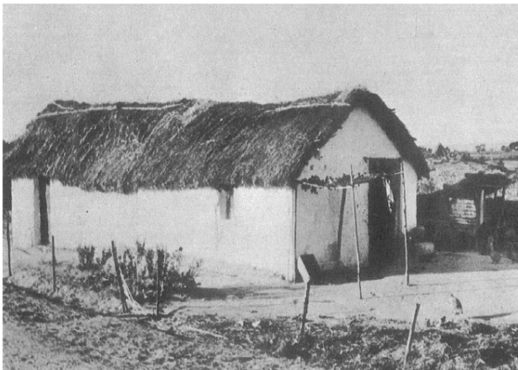
Figura 2.52: Cobertura em colmo — Habitação em Vila Franca de Xira
