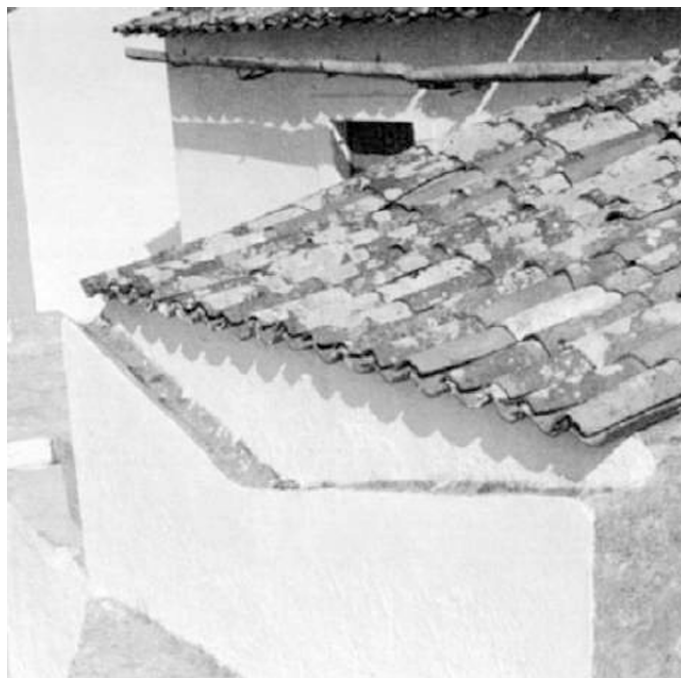
Figura 2.60: Recolha de água para cisterna - Porto de Mós
