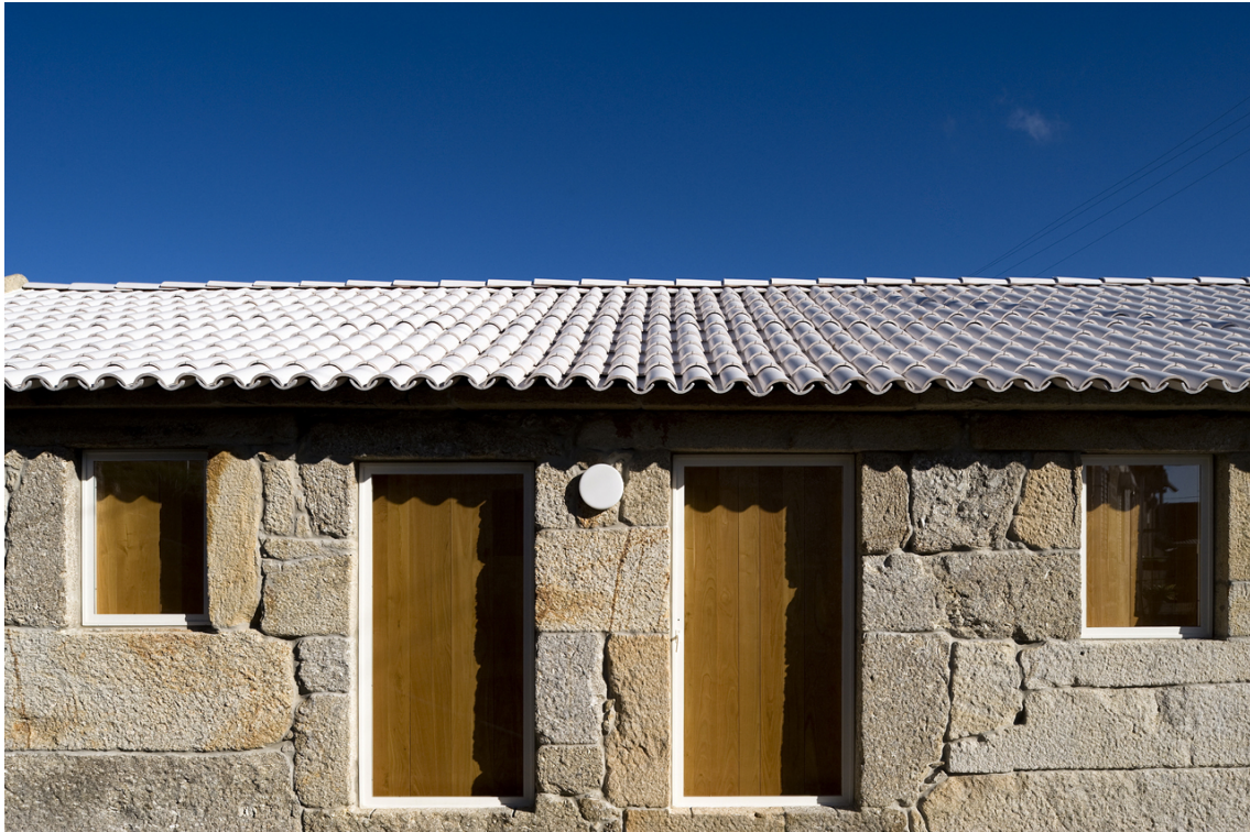
Figura 3.23: Utilização de Telha Cerâmica Pintada de Branco - Casa Clara
