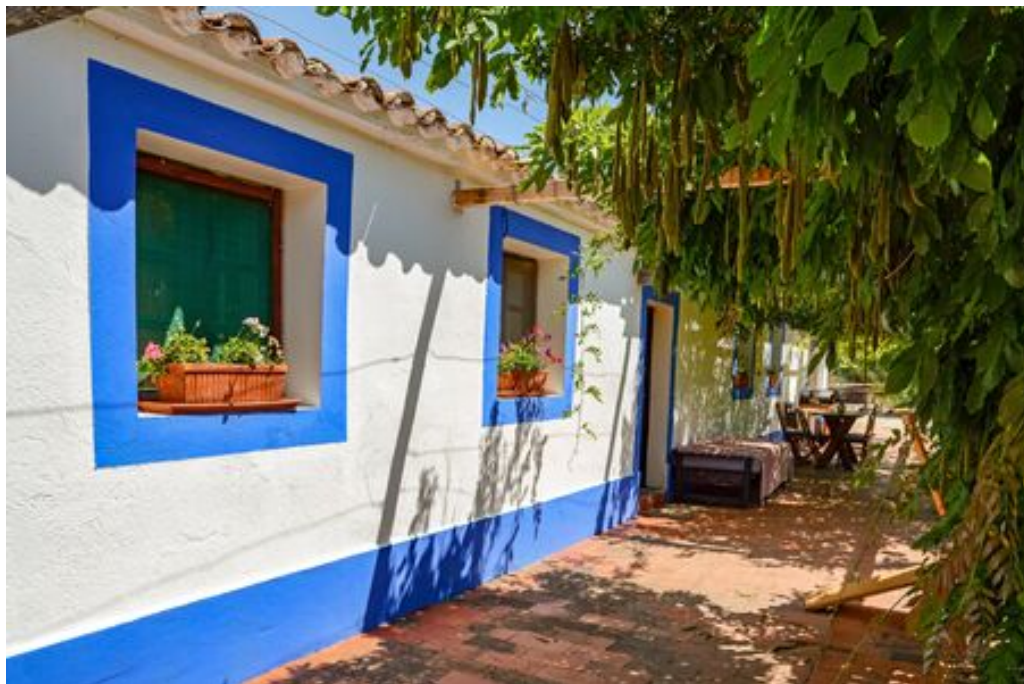
Figura 2.70: Elementos Mitigadores no Exterior da Habitação - Beja
