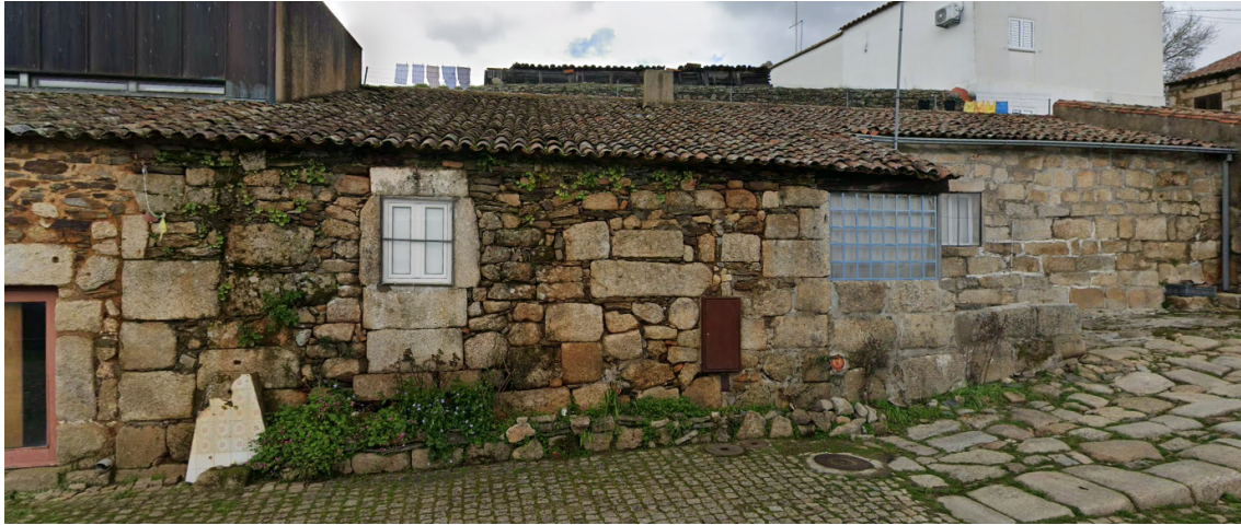
Figura 2.47: Telha Canudo - Idanha-a-Velha
