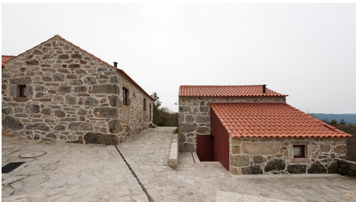
Figura 3.10: Alvenaria em pedra e cobertura em telha cerâmica das habitações (1) - Casas Rurais em Trebilhadouro
