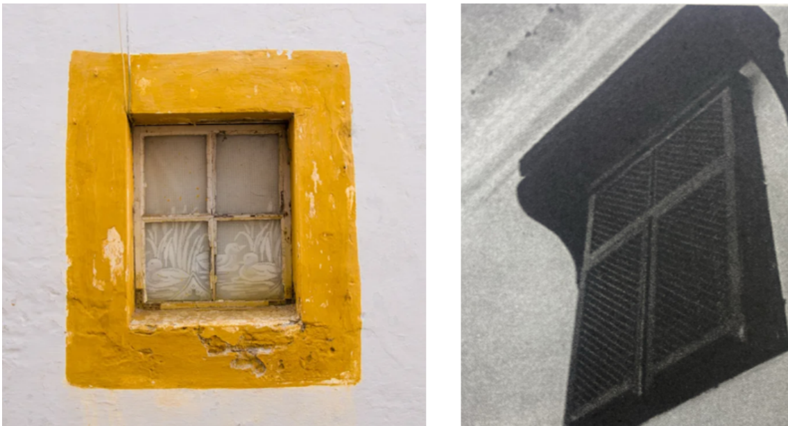
Figura 2.68: Janela de Habitação Alentejana - Évora (Esq.) e Janela Rótula de Habitação Alentejana - Beja (Dir.)
