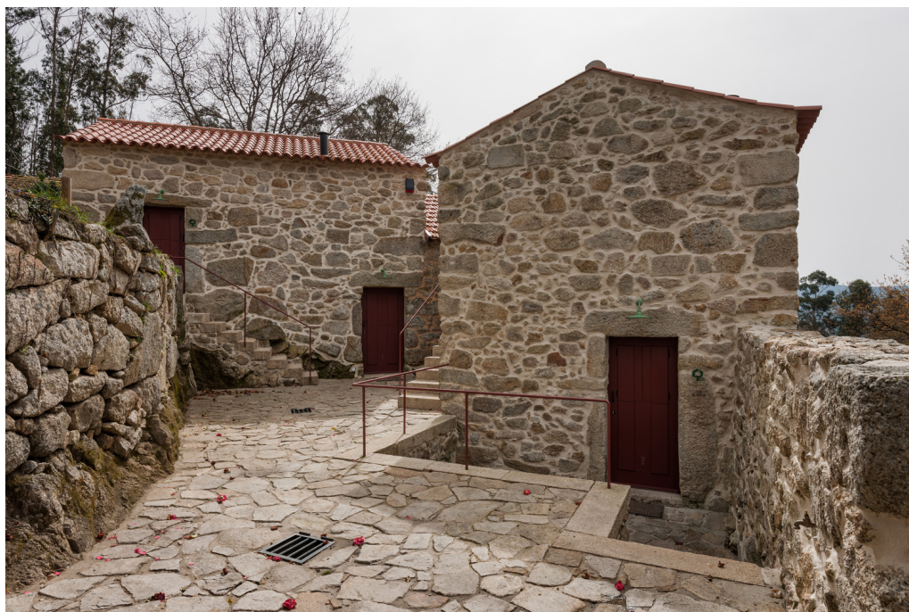
Figura 3.11: Alvenaria em pedra e cobertura em telha cerâmica das habitações (2) - Casas Rurais em Trebilhadouro
