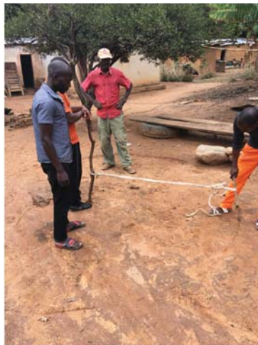
Figura 3.14: Medição da distância entre as estacas
