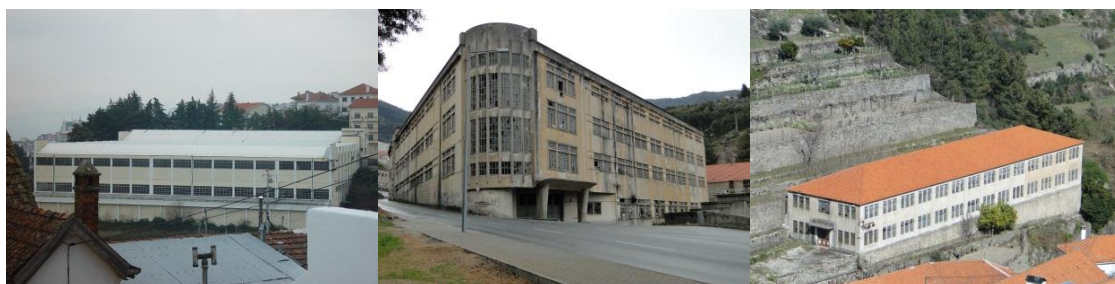
Figura 5.10 - Representatividade de vãos envidraçados nas fachadas, exemplos de edifícios industriais na Covilhã.
