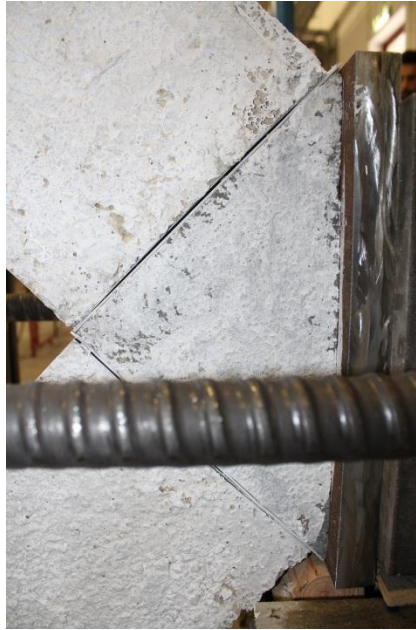
Figura 59 - Imperfeição da face de contacto da cunha com escora
