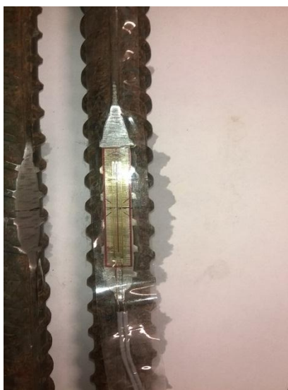
Figura 51 - Colocação dos extensômetros
