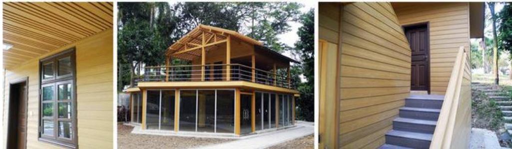
Figura 22 - As aplicações dos WPCs em tetos e revestimentos internos ou externos (Xu et al. , 2022).
